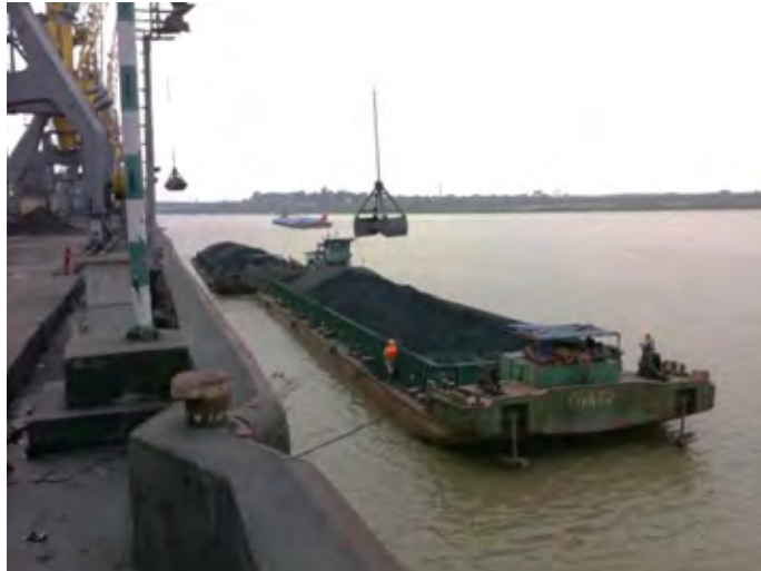
図 2.3-6 揚炭棧橋における定期船からの揚炭状況
