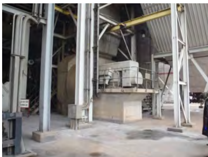
図 2.3-18 Pha Lai II 微粉炭送風機
