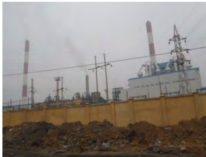
図 3.4-1 Uong Bi 7号機煙突(写真左)、Uong Bi 5,6号機煙突(写真中央)と建設中Uong Bi 7号機煙突(写真右)
