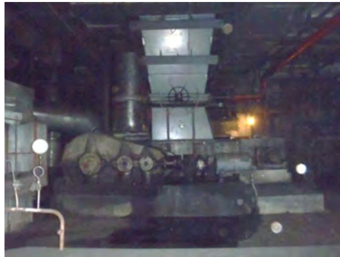
図 2.3-14 Pha Lai II 給炭機
