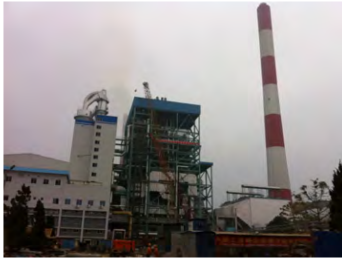
図 3-3 Uong Bi 8号機 建設中 (2012年運転開始予定 300MW)
