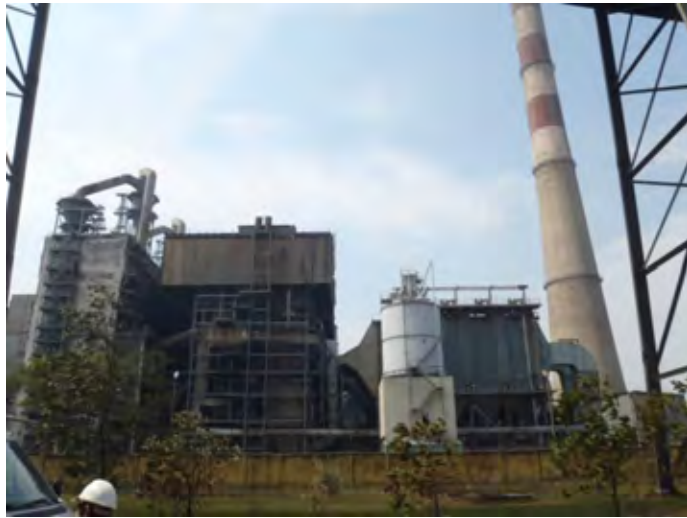
図 2.2-1 Pha Lai I ボイラ外観
