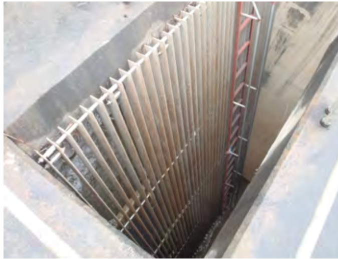
図 2.3-31 Pha Lai II バースクリーン
