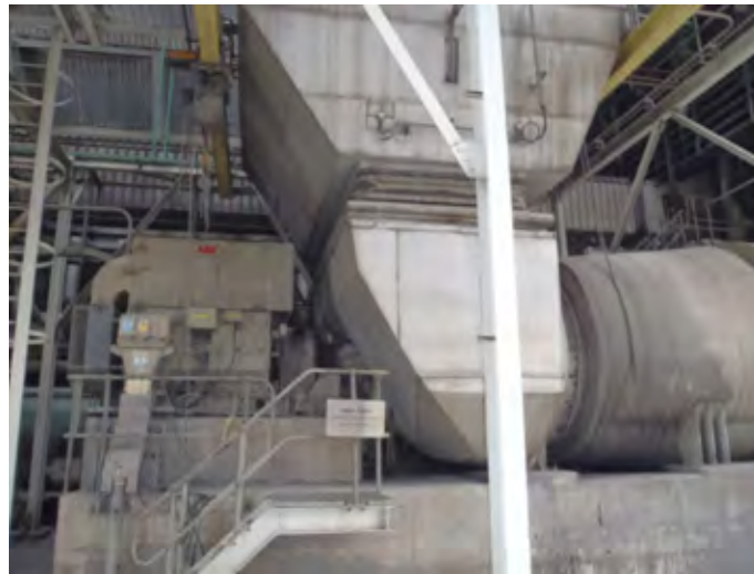
図 2.3-20 Pha Lai II 押込通風ファン
