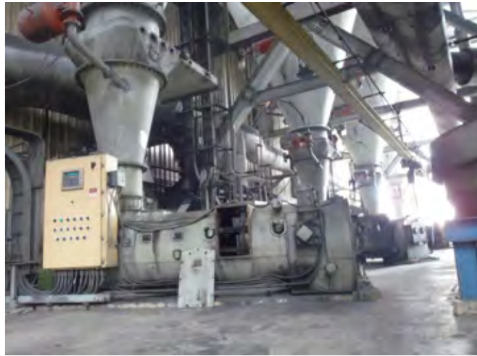
図 2.3-13 Pha Lai I 給炭機
