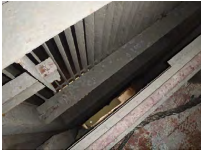
図 2.3-29 Pha Lai I バースクリーン
