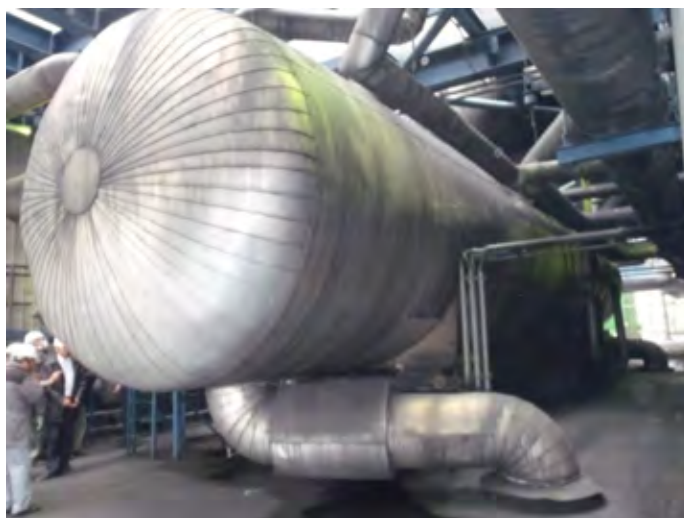
図 3.3-42 Uong Bi 7号機 蒸気ドラム
