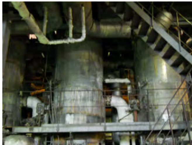
図 2.5-5 Pha Lai I 給水加熱器
