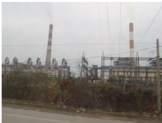
図 2.4-1 Pha Lai I 煙突 ( 写真左 ) , Pha Lai II 煙突 ( 写真右 )
