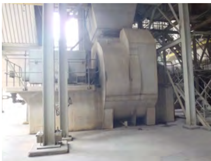
図 2.3-21 Pha Lai II 一次空気押込ファン
