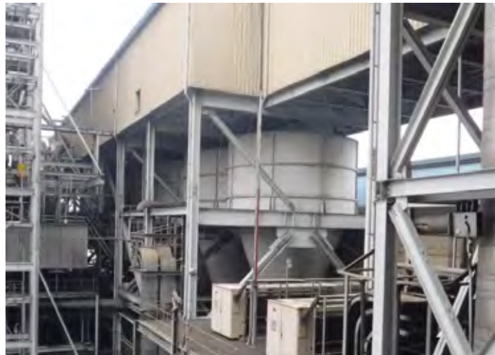
図 2.3-12 Pha Lai II 石炭バンカ
