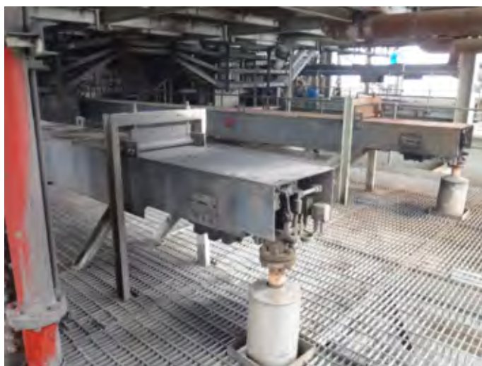
図 2.3-26 Pha Lai I および Pha Lai II のボイラ用ロータリスートブロワ
