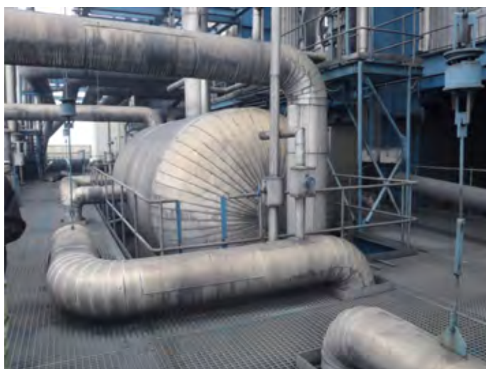
図 3.3-39 Uong Bi 7号機 脱気器
