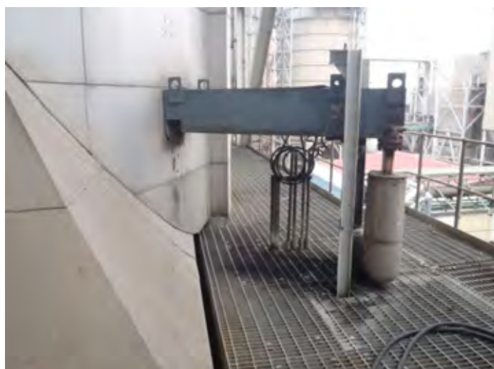
図 2.3-27 Pha Lai II の空気予熱器用ストブプロワ
