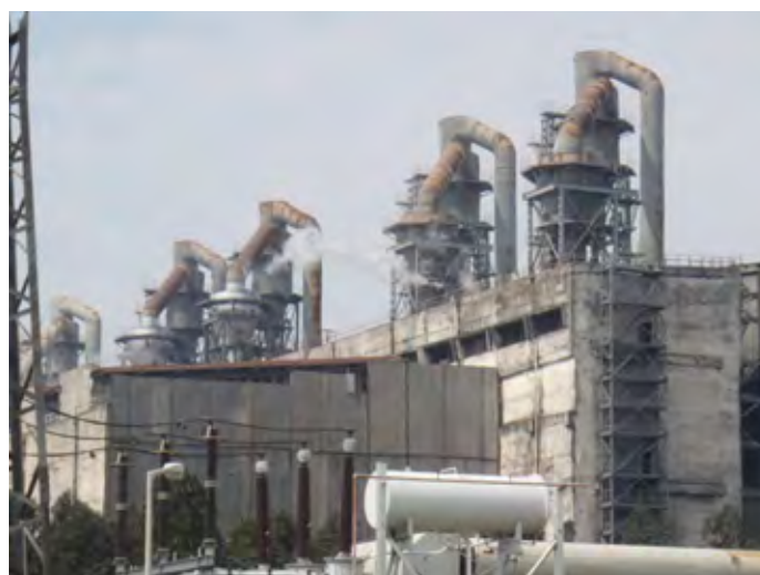
図 2.3-17 Pha Lai I サイクロン分離器
