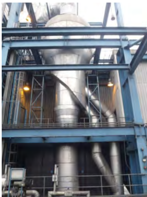
図 3.3-19 Uong Bi 7号機 セパレータ
