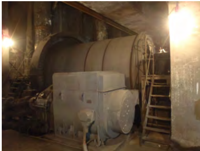
図 3.3-16 Uong Bi 5,6号機 チューブ式ミル
