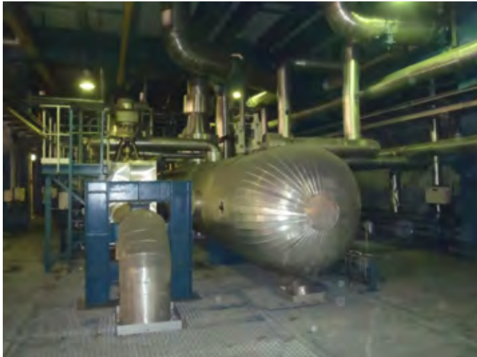
图 3.3-38 Uong Bi 7号機 給水加熱器
