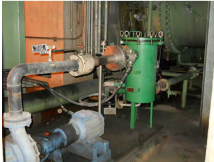
図 2.5-7 ボール洗浄装置
