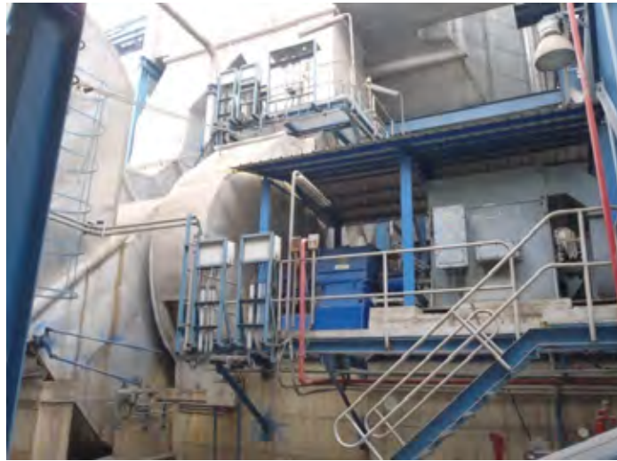
図 3.3-25 Uong Bi 7号機 一次空気押込ファン
