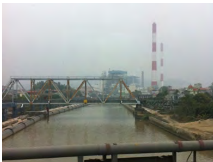
図 3.3-31 発電所までの導水路 (写真左端、川沿いの配管が導水路)
