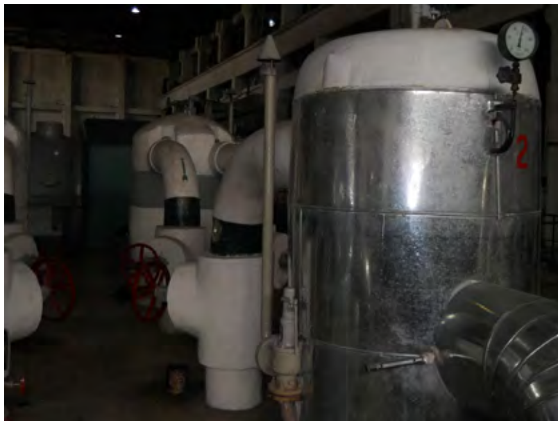
図 1.5-3 給水加熱器
