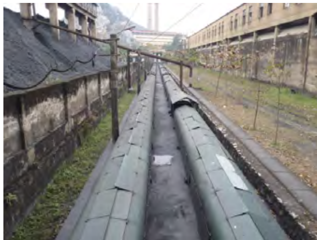
図 1.3-9 屋外のベルトコンベヤ
