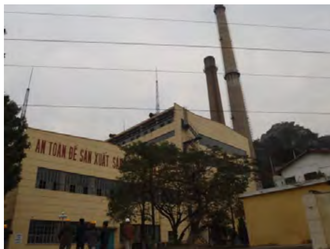
図 1-2 Ninh Binh 火力発電所
