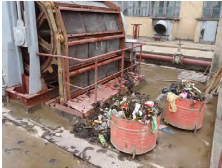
図 1.3-18 異物除去の状況
