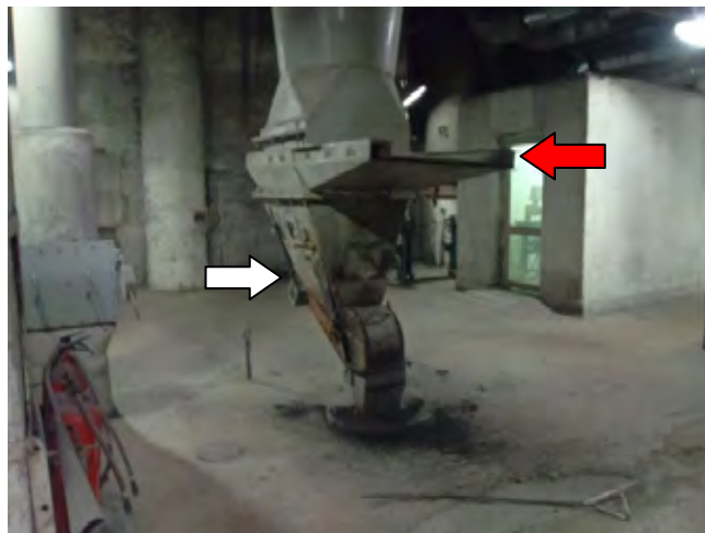
図 1.3-10 バンカ下部給炭機
