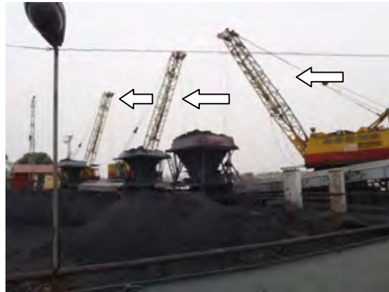
図 1.3-3 揚炭設備全景 (矢印はクラブバケット式自走クレーンを示す)
