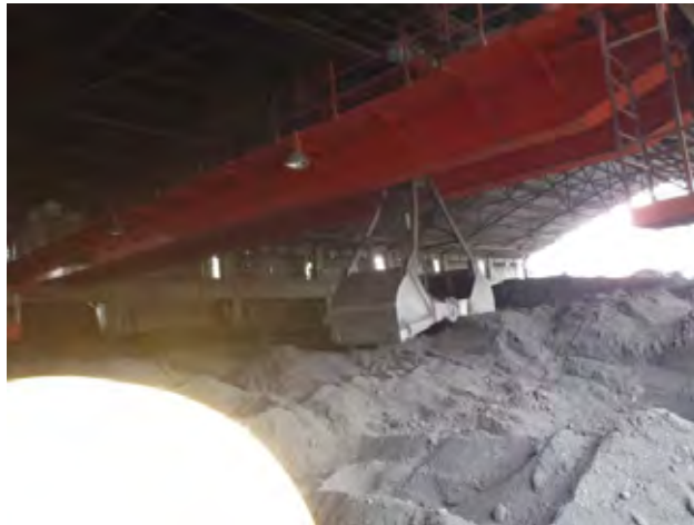
図 1.3-6 屋内貯炭場内状況
