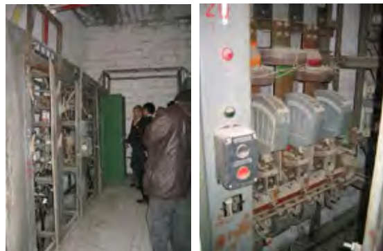
写真-6：既存受変電所内観 1,000kVA 2基、630kVA 2基のトランスが設 置されているが、非常に古く、特別高圧機器 の安全性を危惧する。
