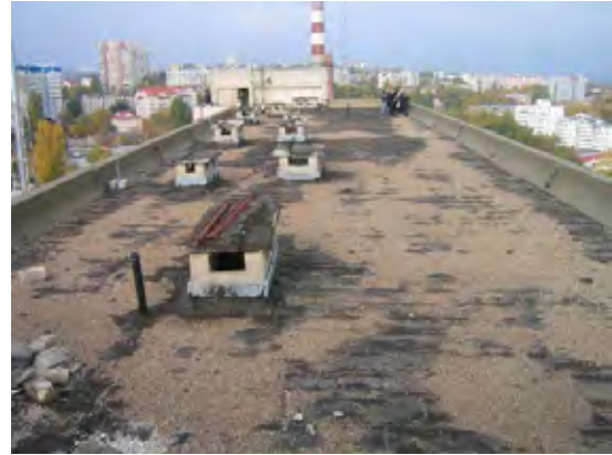
写真-2：病院本館棟屋上 一部防水改修工事を行った。国立腫瘍学研究所内で最も高い建物であるので、受光障害はない。
