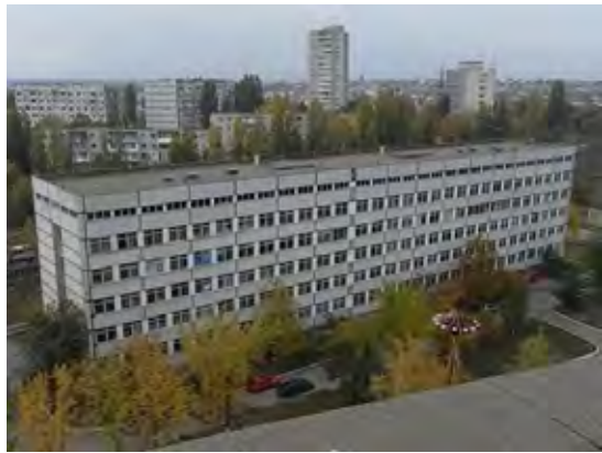
写真-3：外来診療棟全景 1981年竣工の建物。6階建てで屋根面積は約1,500m 2 あり、南側に前面道路もあるため、将来的に日影の問題も少ない。
