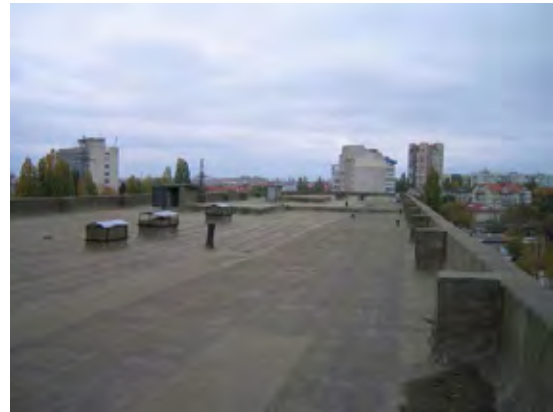
写真-4：外来診療棟屋上 近年改修の防水状態は良く、スラブ耐加重は200kg/m 2 の余裕がある。排気塔も少なく効率的なパネル配列が可能と判断される。
