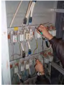
写真左：電圧の事前確認
