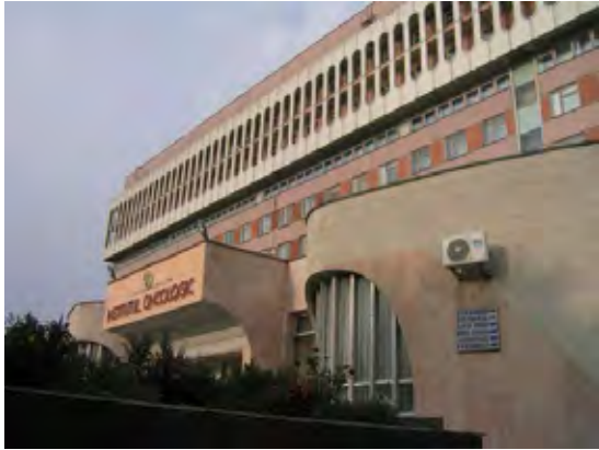
写真-1：病院本館棟外観 1991年竣工の国立腫瘍学研究所病院本館棟。T字型配置の10階建。1階正面玄関屋上にも太陽電池モジュールを設置する。
