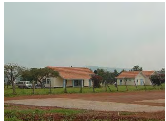
ジンジャ観測所が入居する航空局建屋
