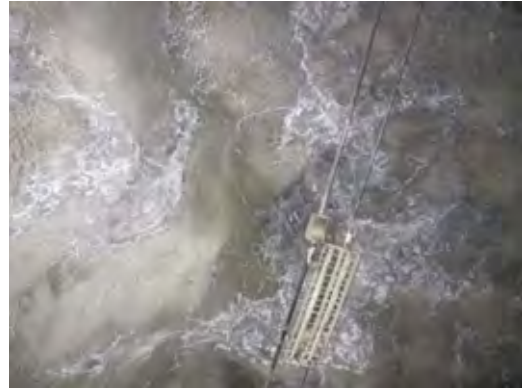
写真-4 トンネル No.1 吹付けコンクリートひび割れ状況（起点側坑口から 140m付近）
