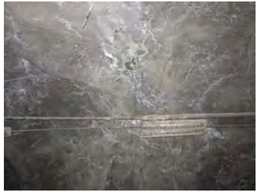
写真-6 トンネル No.1 既設照明の状況
