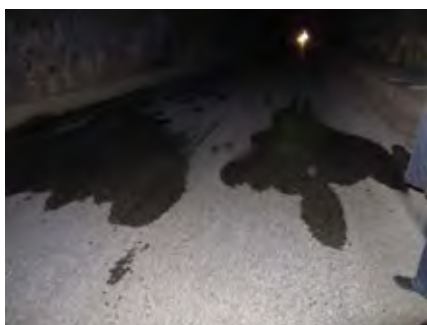
写真-15 トンネル No. 3 漏水状況
