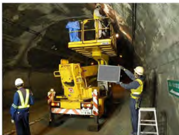
写真-18 高所作業車による作業状況例
