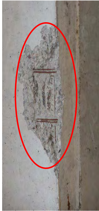
P1-P2 間 G9 桁下フランジに発生した大きなスポーリングと鉄筋露出 (200cmx17cmx50cm) G4,5,6,6,7,8 桁全てに同様のスポーリングが支間中央部に生じている。大規模なスポーリングに対する補修方法である部分コンクリート打設工法やパッチング後に CFRP 補強等適用手法は種々あるが次回詳細点検調査時に比較検討すべき橋梁と判断する。
