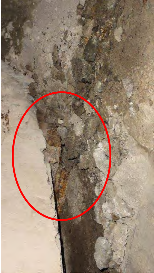
A1 橋台上鋼製支承。土砂に埋まりかかり湿潤状態にあるため腐食した。
