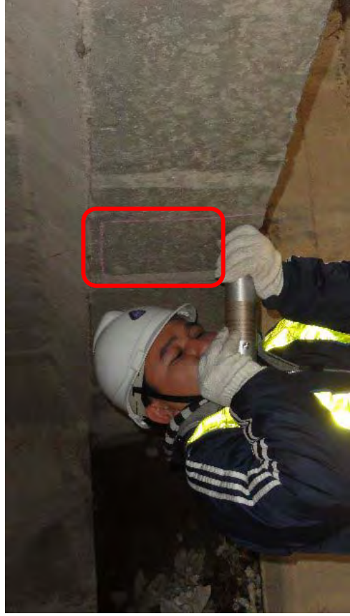
A1 橋台上。支承回りに舗装材が堆積しており清掃が必要。
