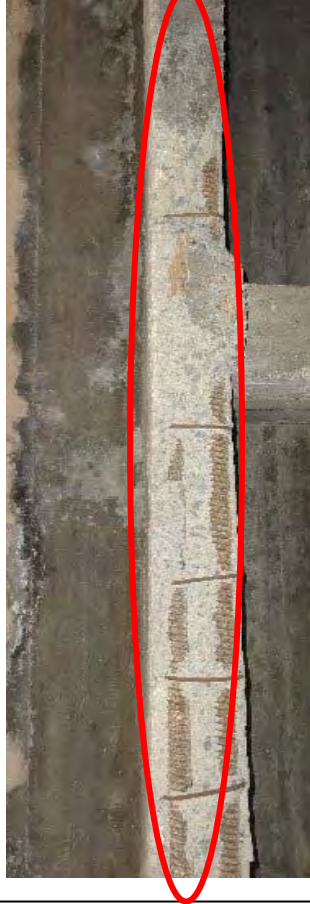
A2 側 G6 桁の下フランジに見られる大きなスポーリング。(200cm x 17cm x 5cm 程度) 主鉄筋露出
