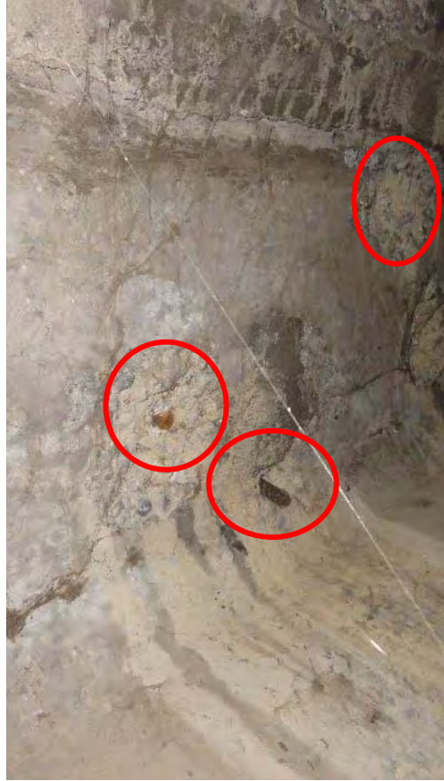
A1 橋台上鋼製支承。土砂に埋まりかかり湿潤状態にあるため腐食した。
