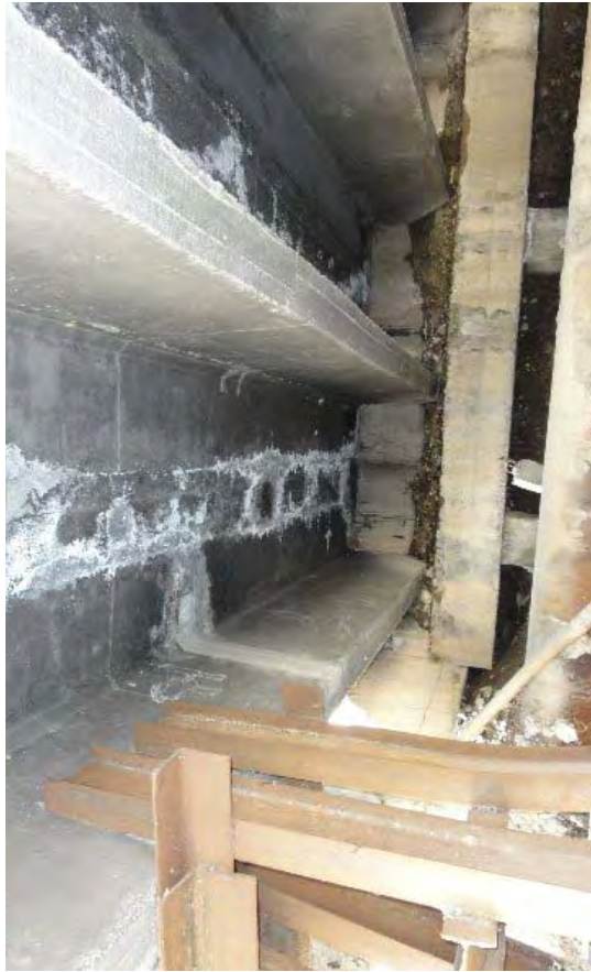
旧橋部床版間詰コンクリート全長に渡る遊離石灰の発生状況。
