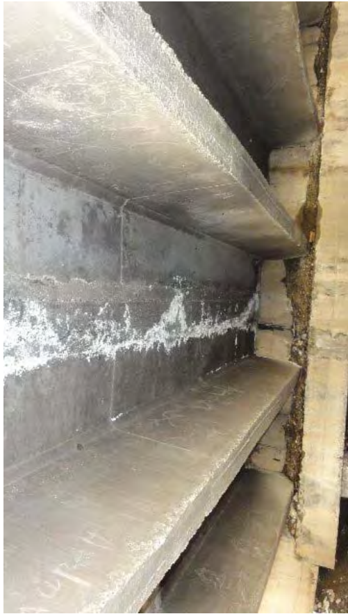
旧橋部床版間詰コンクリート全長に渡る遊離石灰の発生状況。
