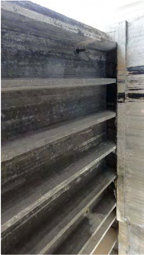
旧橋部上部工の状況。排水管よりの漏水が目立つ程度。遊離石灰は若干全体に広がる。
