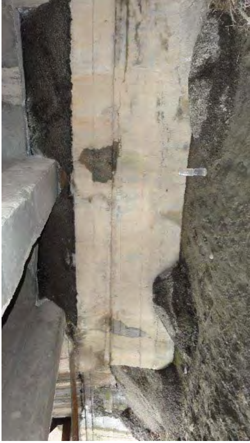
A1 橋台上。支承回りに舗装材が堆積しており清掃が必要。
