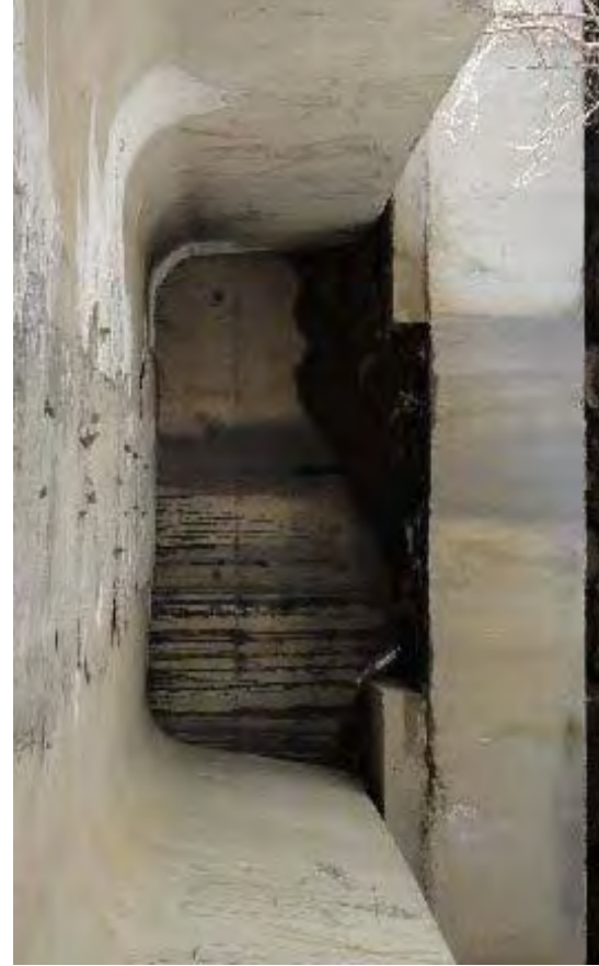
A1 橋台の拡幅側で 3 本の RC 杭で 3 本の主桁を支持している。
