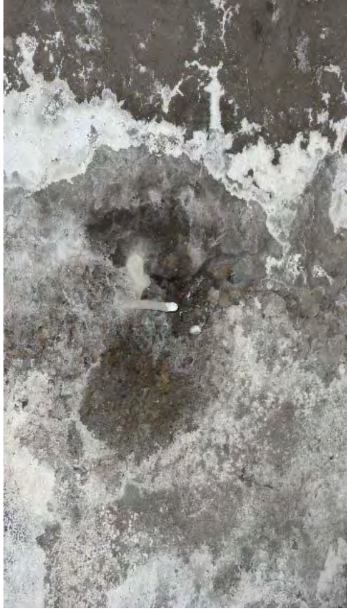
P2-A2 間、G8-G9 桁間床版に写真のように漏水により遊離石灰が鍾乳石として発達している場所が数カ所見られた。
