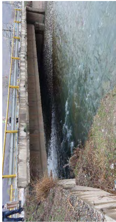
A2 橋台を望む。河川流が直接橋台に当たり、洗掘が進んでいる。河川流を変更するのは位置的に困難なため 1m 以上の岩を多数沈設して洗掘防止工として設置することが望ましい。
