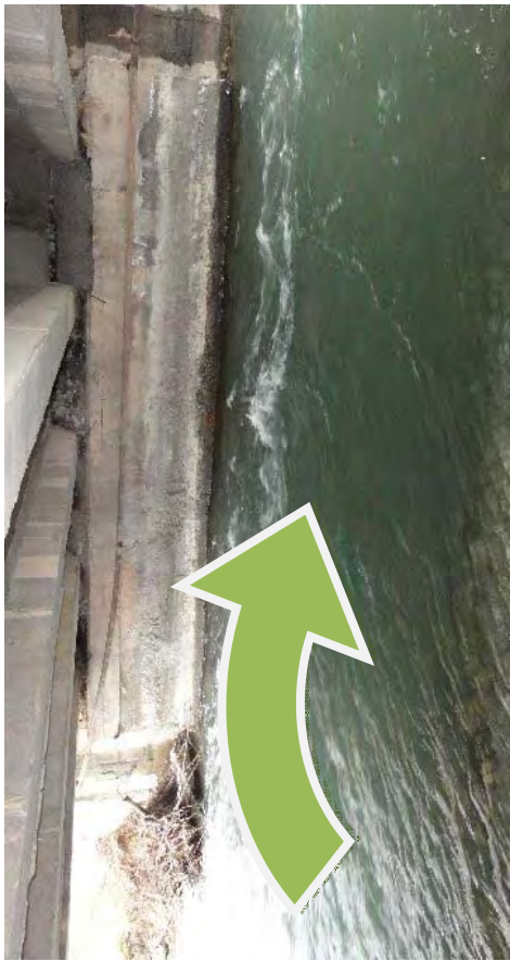
A2 橋台を望む。河川流が直接橋台に当たり、洗掘が進んでいる。河川流を変更するのは位置的に困難なため 1m 以上の岩を多数沈設して洗掘防止工として設置することが望ましい。
