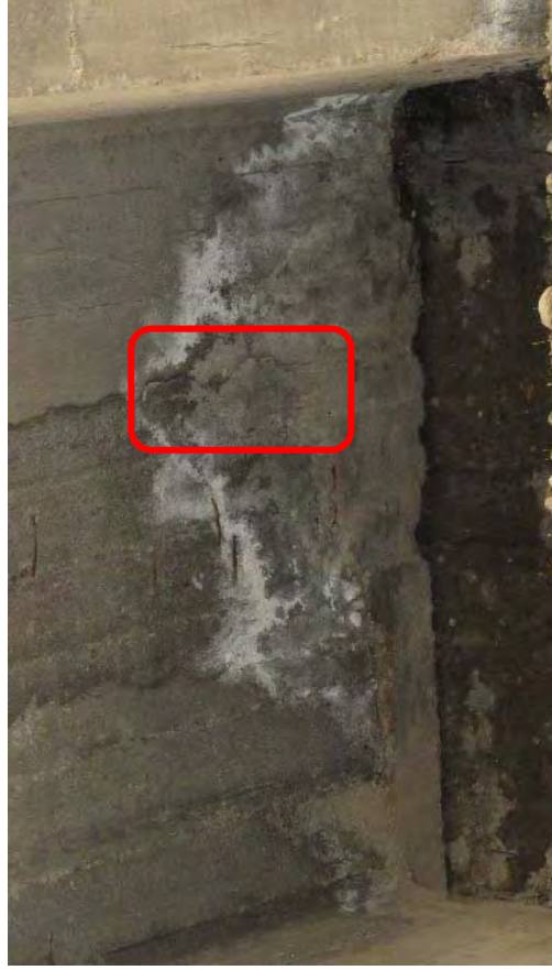
旧橋部上部工の状況。排水管よりの漏水が目立つ程度。遊離石灰は若干全体に広がる。
