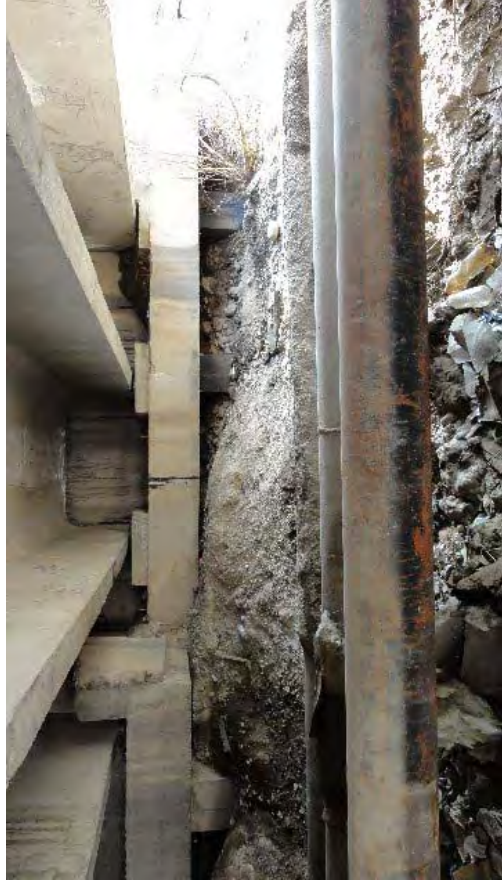
A1 橋台の拡幅側で 3 本の RC 杭で 3 本の主桁を支持している。
