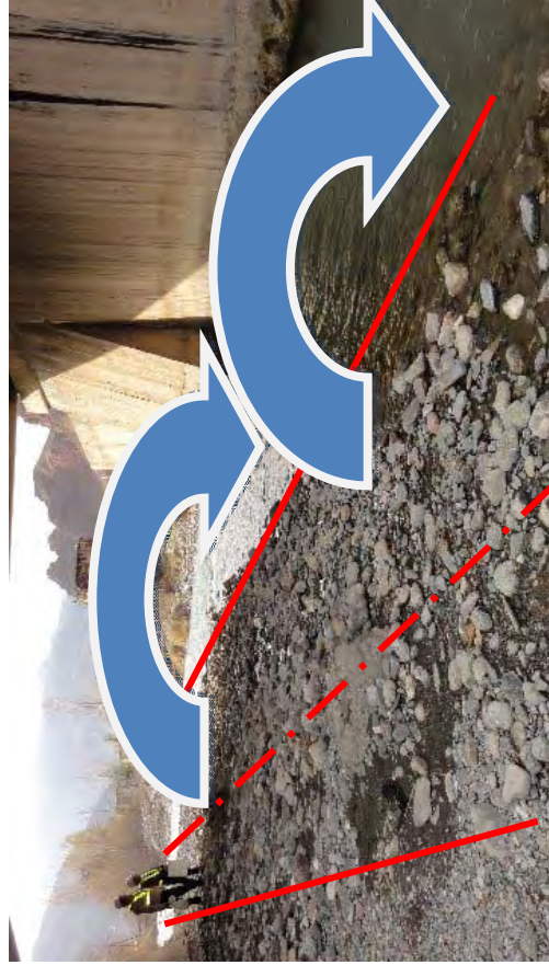
上流側。左側がビシュケク側。右側がオシユ側。河川流が左から右に振られてきているのが分かる。
