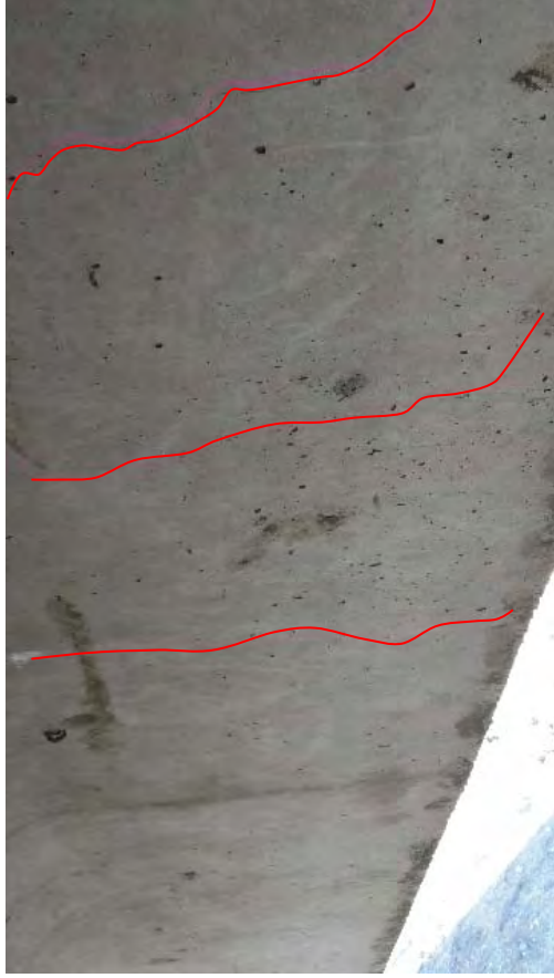
各桁にせん断クラックが数多く見られたが、今のところクラック幅は大きくないが定期点検時の確認が必要。
