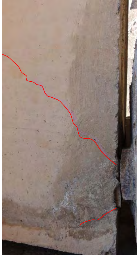
A1 橋台支承は鋼板プレート型で若干腐食しており塗装が必要。支承周りはきれいな状態に保たれている。上沓と下沓のずれは特に問題ない。
