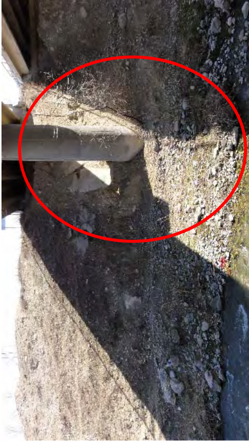
A1 橋脚部スローププロテクションは、大部分損傷している。再度斜面 保護工の設置が望ましい。
