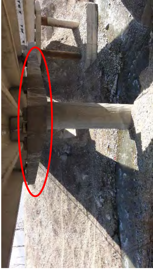
P2 橋脚より A2 橋台を望む。G4 桁と G5 桁間に遊離石灰が全長に見られる。間話コンクリートとの境界からの漏水を示す。
