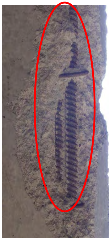
A1 橋台部桁間遊間約 5cm。片側の鋼アングル材と重ね鋼板が無くなっている。P3,P4,P5,A2 も同様の損傷状態である。P1,P2 上はまた伸縮装置が機能しているが、他と同様の損傷状態に移行すると思われる。走行性と桁伸縮を同時に満足できるアスファルトプラグジョイント形式で補修するのが望ましい。
