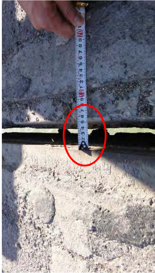
A1 橋台部桁間遊間約 5cm。片側の鋼アングル材と重ね鋼板が無くなっている。P3,P4,P5,A2 も同様の損傷状態である。P1,P2 上はまた伸縮装置が機能しているが、他と同様の損傷状態に移行すると思われる。走行性と桁伸縮を同時に満足できるアスファルトプラグジョイント形式で補修するのが望ましい。
