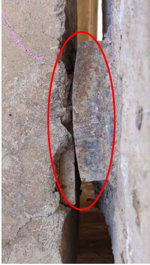
A1 橋台支承は鋼板プレート型で若干腐食しており塗装が必要。支承周りはきれいな状態に保たれている。上沓と下沓のずれは特に問題ない。
