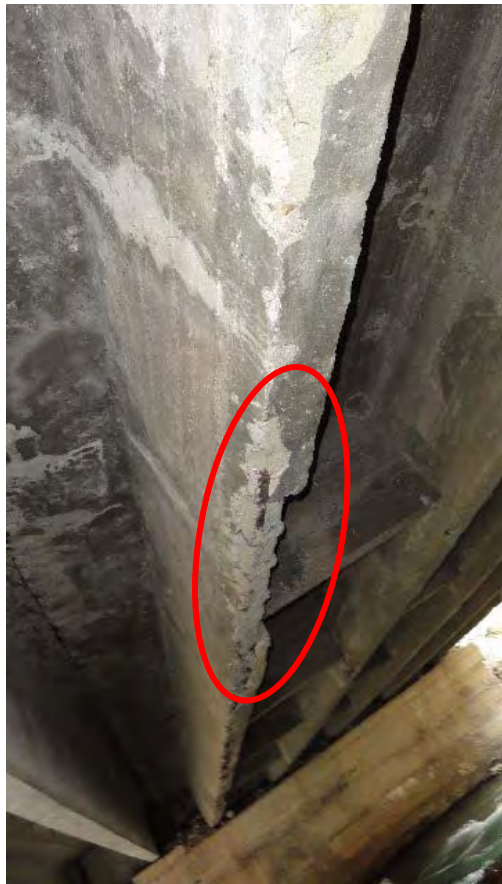
旧橋側 G6 桁の下フランジに見られる大きなスポーリング。 (200cmx17cmx4cm 程度) 主鉄筋露出。
