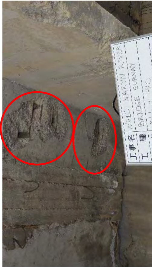
A2 橋台付近 G1 桁スポーリング。鉄筋露出有り。
