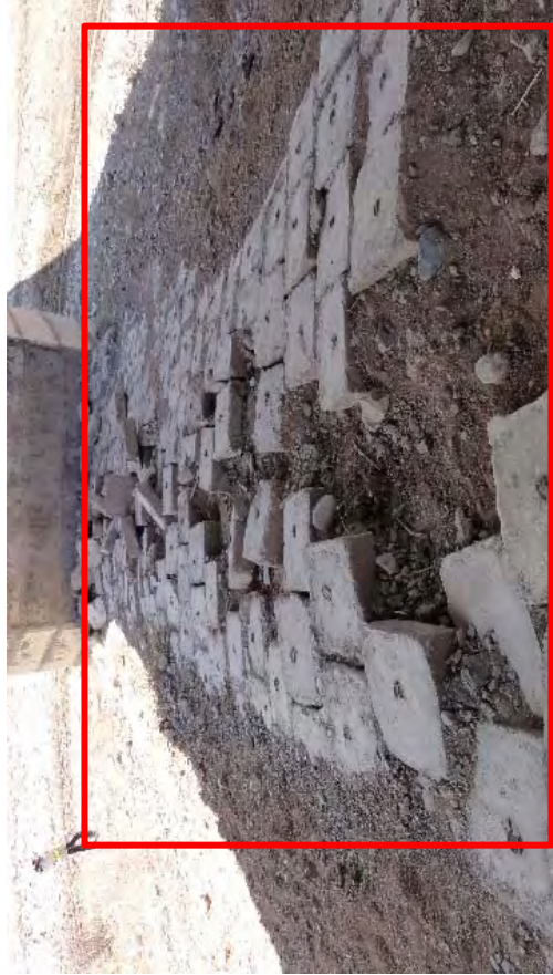
PCT 桁区間の状況。若干間詰コンクリート部を中心に遊離石灰が見られる。
