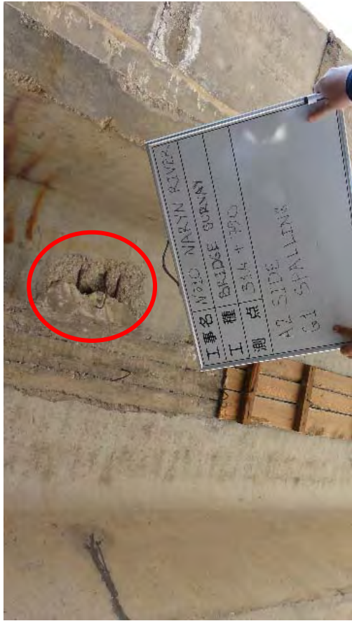
A2 橋台付近 G1 桁スポーリング。鉄筋露出有り。
