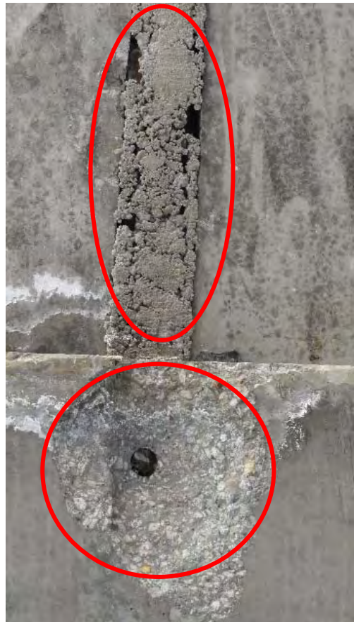
PCT 桁区間の状況。若干間詰コンクリート部を中心に遊離石灰が見られる。
