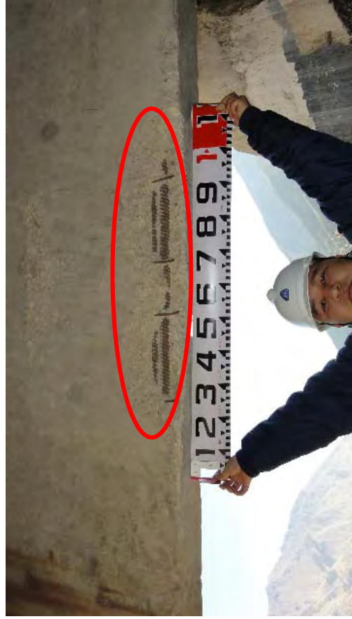
間詰コンクリート部より遊離石灰が発生。少量の漏水有り。
