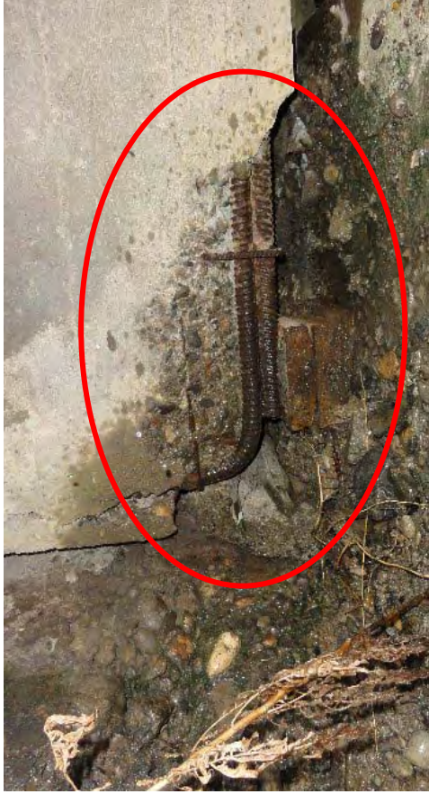
G1 桁 A2 橋台支点上のスポーリング。完全に主鉄筋が露出しており、反力を主鉄筋が直接鋼製支承に伝えている状態。至急補修の必要性がある。次回詳細点検時にパッチング補修のパイロット補修として実施が望まれる。
