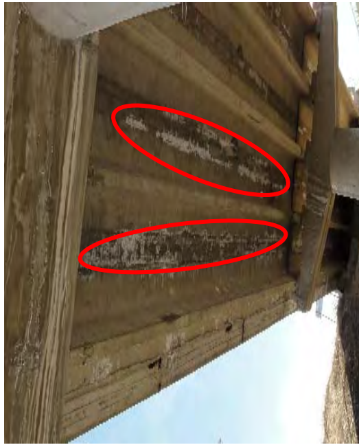
P2 橋脚より A2 橋台を望む。G4 桁と G5 桁間に遊離石灰が全長に見られる。間話コンクリートとの境界からの漏水を示す。
