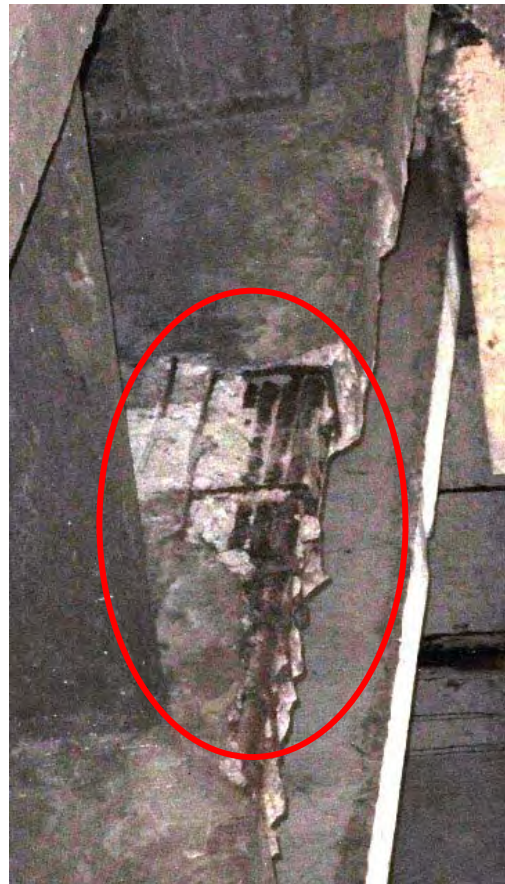
旧橋側 G6 桁の下フランジに見られる大きなスポーリング。 (200cmx17cmx4cm 程度) 主鉄筋露出。
