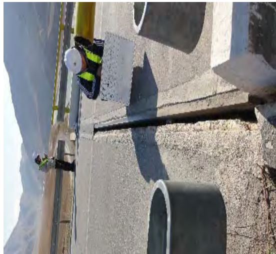
P2,P3 橋脚の状況、杭も現れておらず洗掘は生じていないと思われる。
