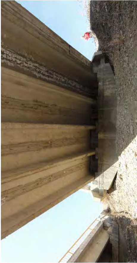
P2 橋脚より A2 橋台を望む。G4 桁と G5 桁間に遊離石灰が全長に見られる。間話コンクリートとの境界からの漏水を示す。
