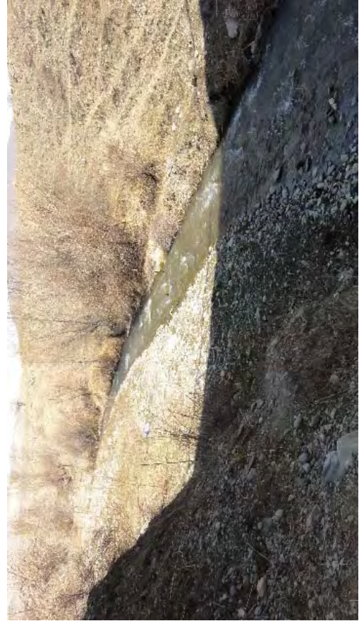
A1 橋脚部スローププロテクションは、大部分損傷している。再度斜面 保護工の設置が望ましい。
