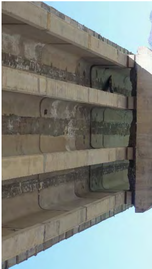
PCT 桁区間の状況。若干間詰コンクリート部を中心に遊離石灰が見られる。
