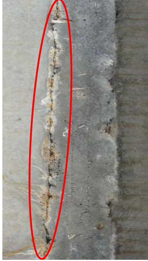
間詰コンクリート部より遊離石灰が発生。少量の漏水有り。
