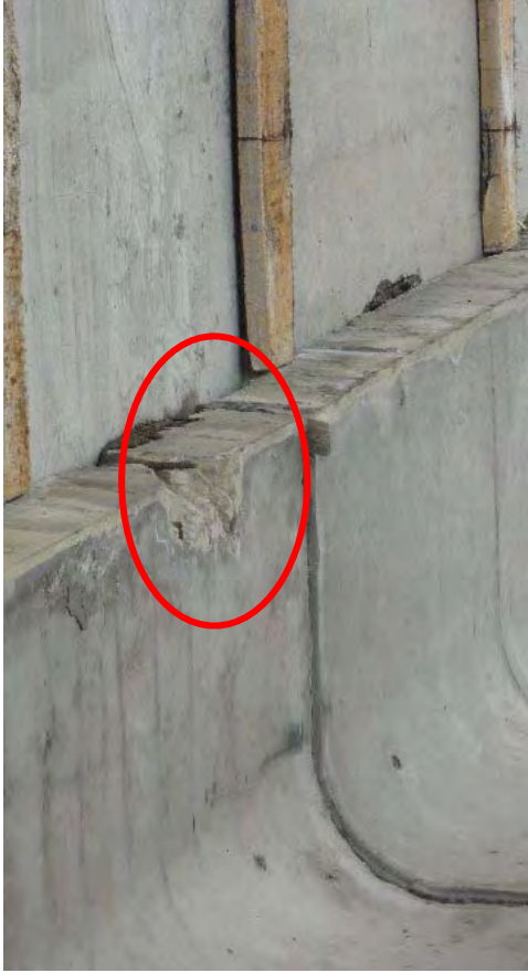
G1 桁 A2側より3ブロック目のスラブ端部に発生したスポーリング (20cmx15cmx10cm)
