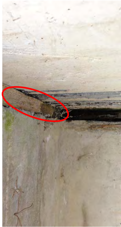
A2側 G1桁とG2桁間の間詰コンクリートの一部にバイブレーター不足によるハニカムが見られる。鉄筋も一部露出しておりパッチング補修が望ましい。(40cm x 100cm x 5cm)
