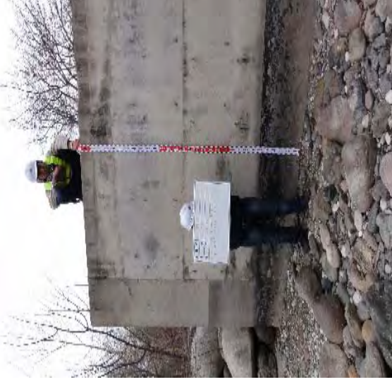
ウイングの高さはおよそ 3.2m で壁厚 50cm となっている。
