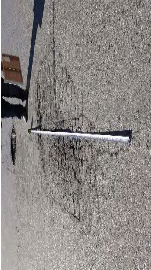
A2側より約16m位置の舗装クラック。ポットホールへの進展と周辺部への広がりをみせている。
