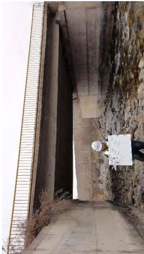
アスファルト舗装に生じたクラック。橋台と橋桁の遊間部のクラックが 右側で左側の大きなクラックはアプローチスラブ前縁端部と思われる。 A1 部、A2 部共通
