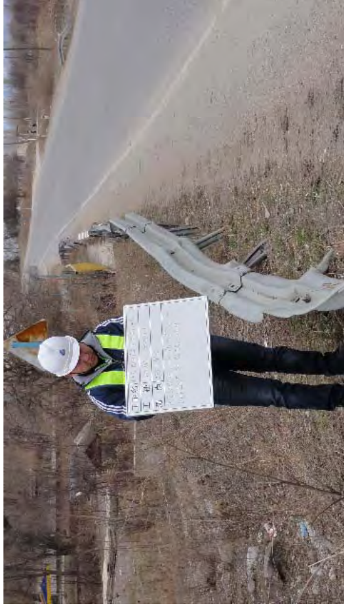
アプロローチ部ガードレールの事故による損傷状況 (左側)
