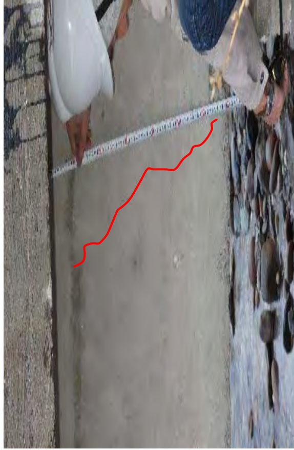
主桁と橋台の遊間は、約5cmである。
