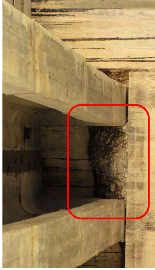
A2 橋台を望む。5 主桁橋。A2 側が Fix で鋼板プレート支承が適用されている。
