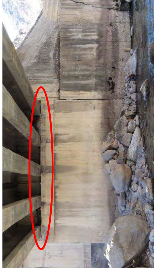
A2 橋台右側ウイングのクラック。コーキング補修が望ましい。
