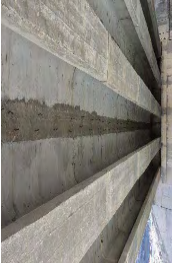
間詰コンクリート部に遊離石灰が見られ健全な状態を維持している。
