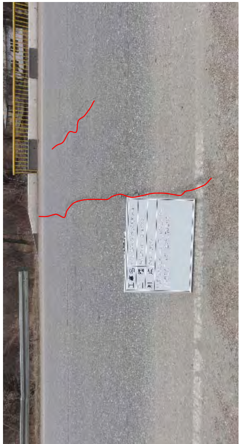
アスファルト舗装に生じたクラック。橋台と橋桁の遊間部のクラックが 右側で左側の大きなクラックはアプローチスラブ前縁端部と思われる。 A1 部、A2 部共通
