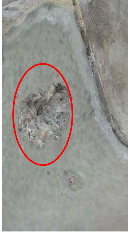
G1 桁 A2側より3ブロック目のスラブ端部に発生したスポーリング (20cmx15cmx10cm)
