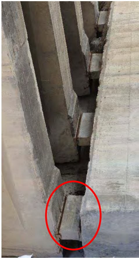
A1 橋台上ロッカー支承は健全な状態を維持しているが、鋼材が腐食しているので塗装が望ましい。
