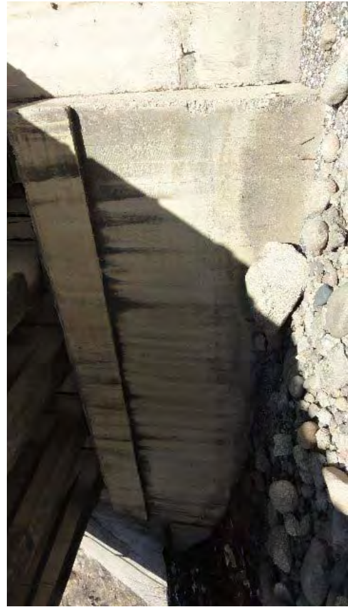
A1 橋台付近 G5 桁シュミットハンマーによる強度確認を実施した。 47.7MPa と PC 桁として十分な強度を有している。
