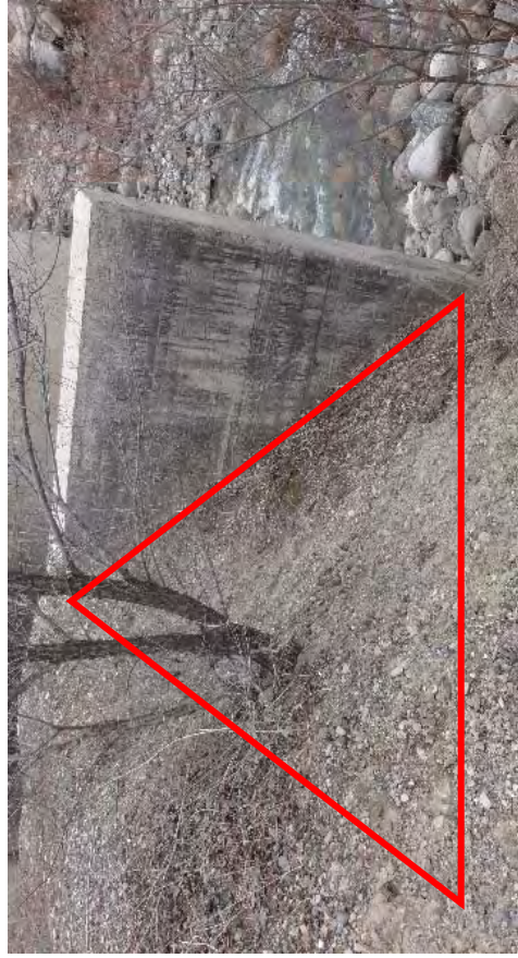
ウイングの高さはおよそ 3.2m で壁厚 50cm となっている。
