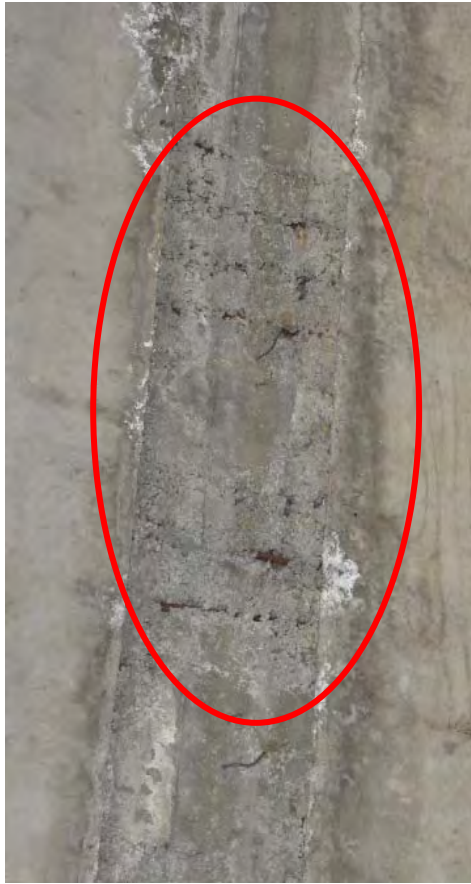
A2側 G1桁とG2桁間の間詰コンクリートの一部にバイブレーター不足によるハニカムが見られる。鉄筋も一部露出しておりパッチング補修が望ましい。(40cm x 100cm x 5cm)
