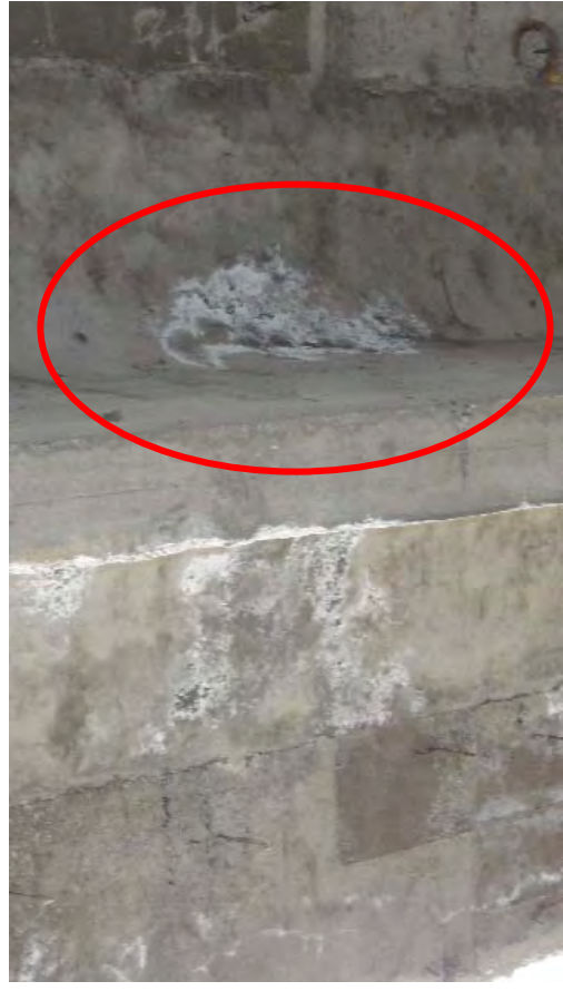
G7 桁に発生した遊離石灰分、両サイドに発生しており T 桁上面にクラック発生していると考えられる。
