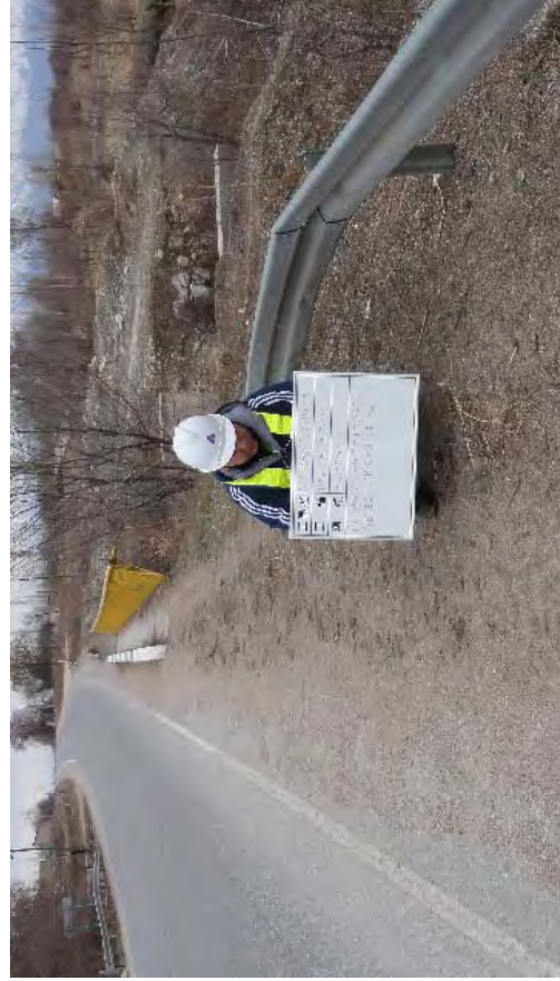
アプロローチ部ガードレールの事故による損傷状況 (左側)
