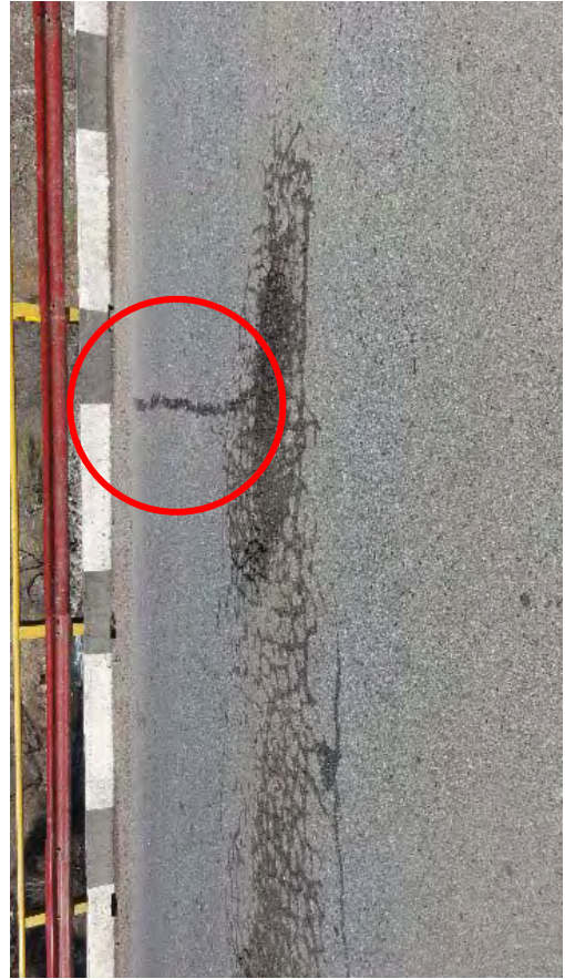
A2側より約16m位置の舗装クラック。ポットホールへの進展と周辺部への広がりをみせている。
