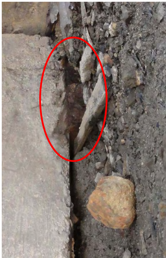
拡張側の新しい方のT桁のG1桁に数カ所にわたり写真のようなせん断クラックが発生していた。
