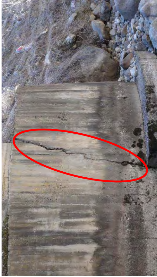
A2 橋台右側ウイングのクラック。コーキング補修が望ましい。
