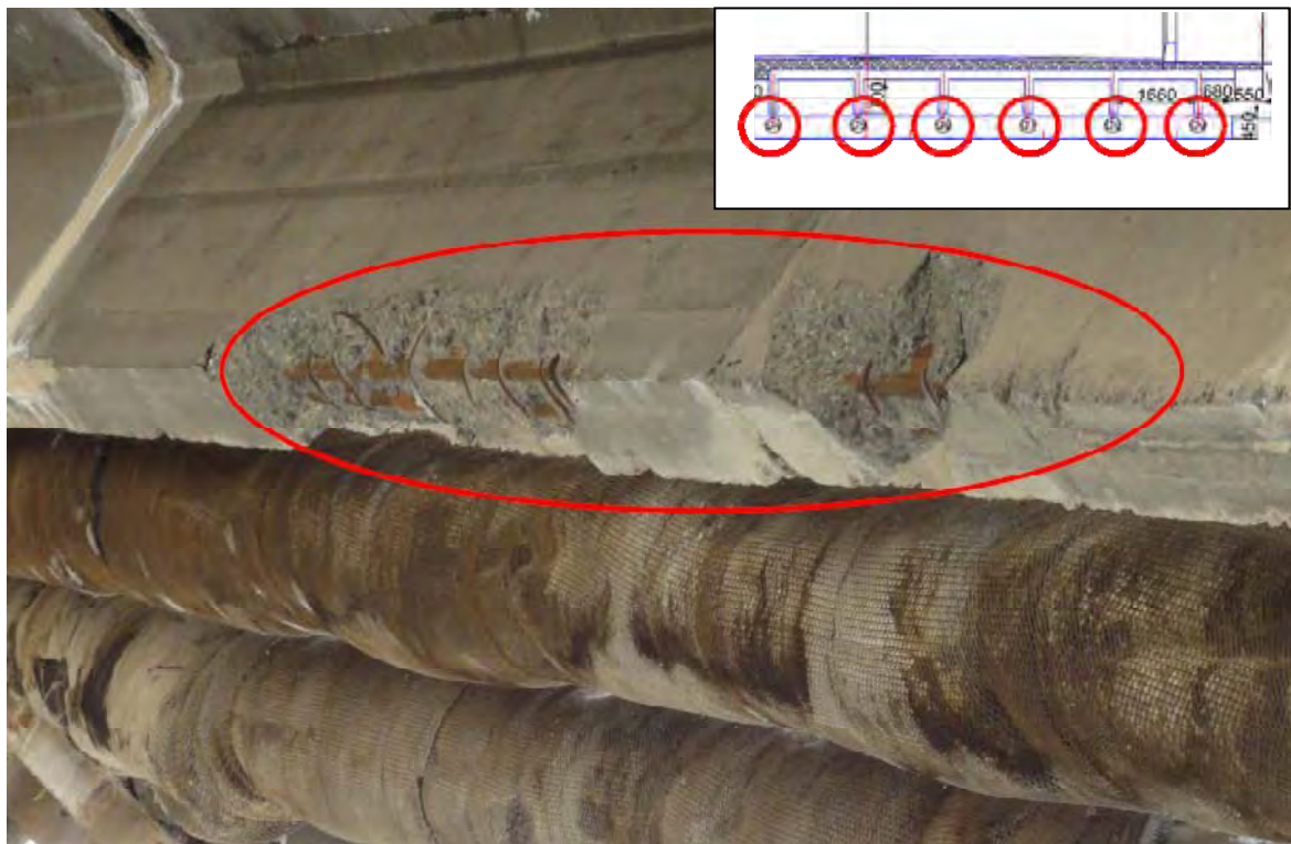
写真 6 (4) No.17 Karakul II 橋
