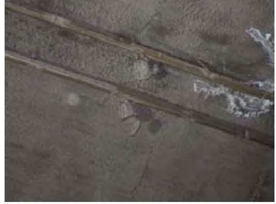
写真 トンネル No. 2 設備状況
