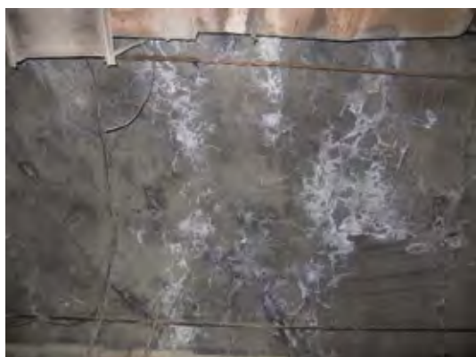
写真 トンネル No. 2 ひび割れ発生状況（坑口から 180m 付近）
