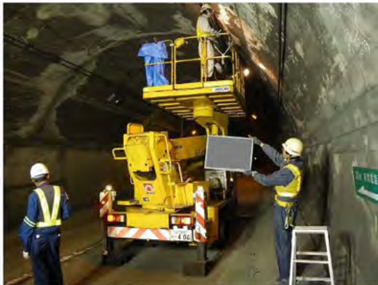
写真 高所作業車による作業状況例
