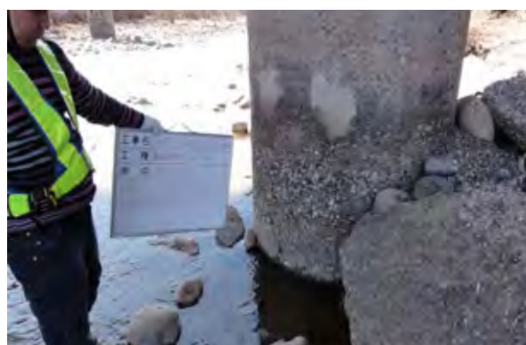
№ 6 Torken 川橋 洪水時に多数の小石が衝突し摩滅している
