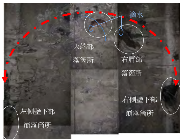
図-23 トンネル No. 2 の崩落箇所
