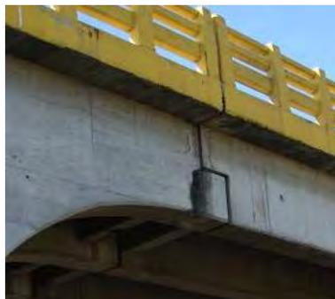
Foto 3-2-2 Estado del soporte de la viga en ménsula de celosía
