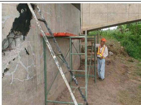
Foto-8 Andamio instalado para investigar el nivel de solidez de la pila P1
