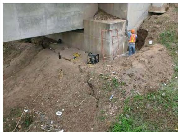
Foto-9 Estado de raspado del concreto del estribo A1
