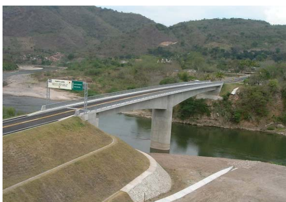
写真-15 イラマ橋新橋竣工時全景
