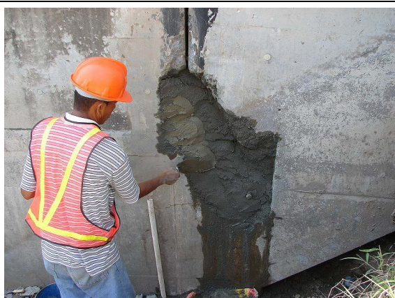
写真-13 健全度件調査後の復旧状況
