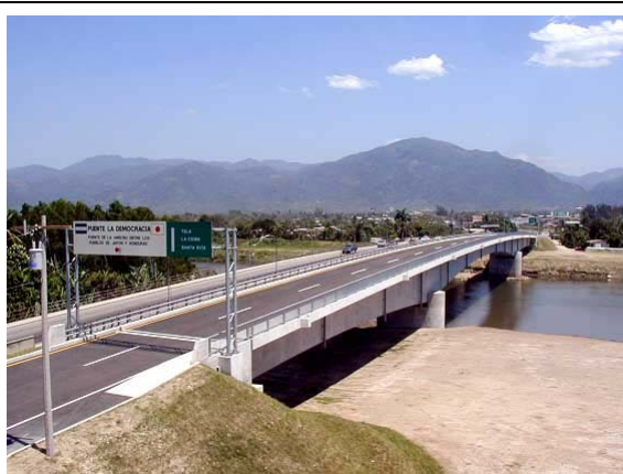
写真-1 デモクラシア新橋竣工時全景
