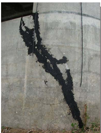
写真3-5-1 橋脚落橋防止装置 ひびわれ防水対策状況
