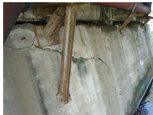
写真 3-2-7 A1 橋台の状況
