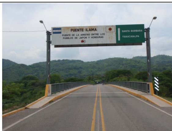
写真-16 イラマ橋被災前
