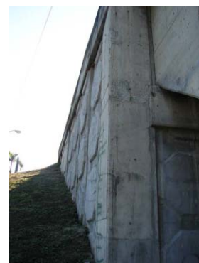
写真 3-2-3 橋台部の状況
