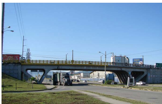
写真 3-2-1 メガプラザ橋
