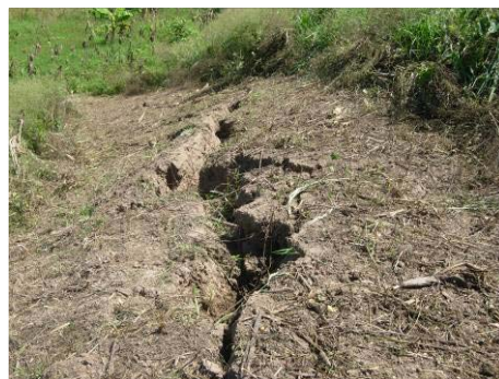
写真 3-8-2 堤防の亀裂
