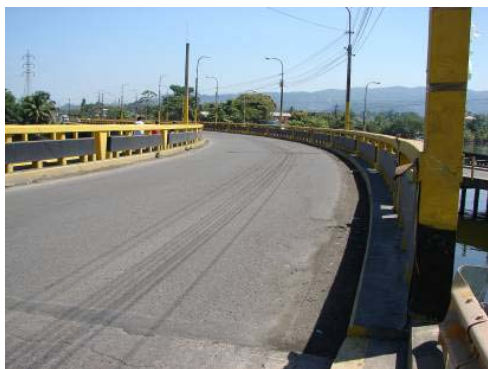
写真 3-2-6 コルテス港近傍の橋梁
