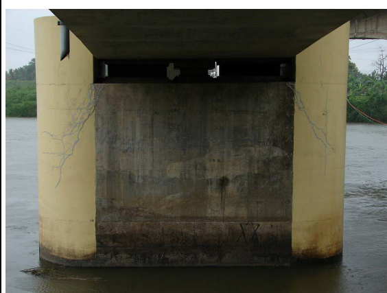
写真-6 P2 橋脚正面図(A2 橋台側から撮影)
