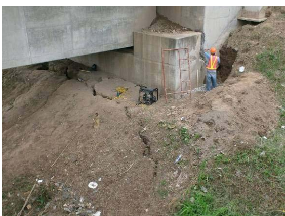
写真-9 A1 橋台コンクリート取り壊し調査状況
