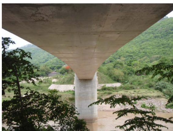
写真-17 イラマ橋主桁の状況
