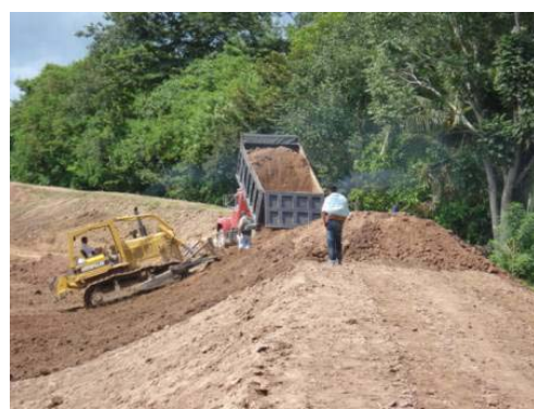
写真3-5-3 デモクラシア新橋付近 堤防補修対策状況
