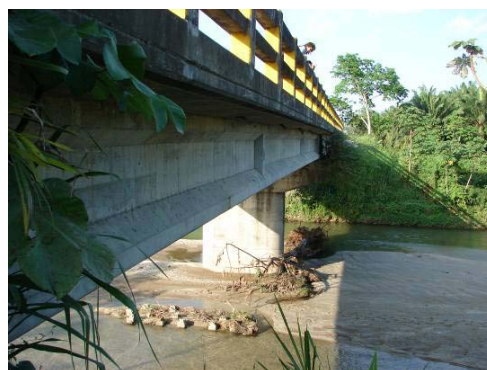
写真 3-2-8 サンアヘロ川橋
