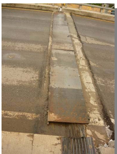
写真3-5-2 伸縮継手 破損断差対策状況
