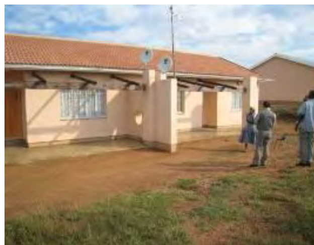
写真-5：教員住宅（2 戸 1 棟タイプ） 安定した教員確保のために必要不可欠な施設として多くの学校に付設されている。特に農村部に多い。
