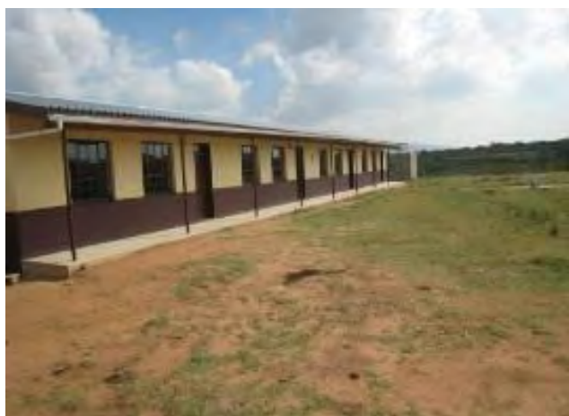
写真-1：既存校教室棟外観 解放廊下の柱は鋼管ペンキ仕上げ、屋根は波型亜鉛鍍鉄板葺き
