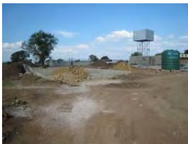
写真-6：既存校の給水設備 受水槽（緑のタンク）から高架水槽に圧送し、各施設に重力給水する方法を取っている。
