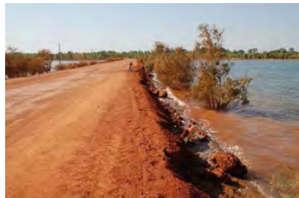
Après le rechargement le 26 Nov. 2010
