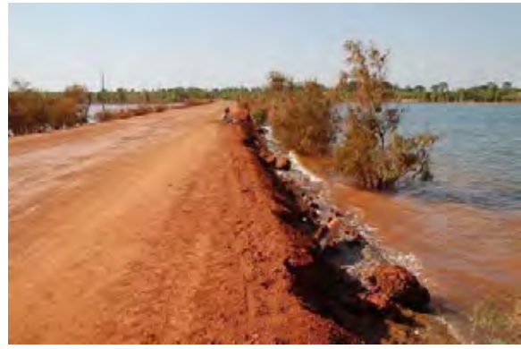
写真 冠水後 道路嵩上げ 2010年11月26日
