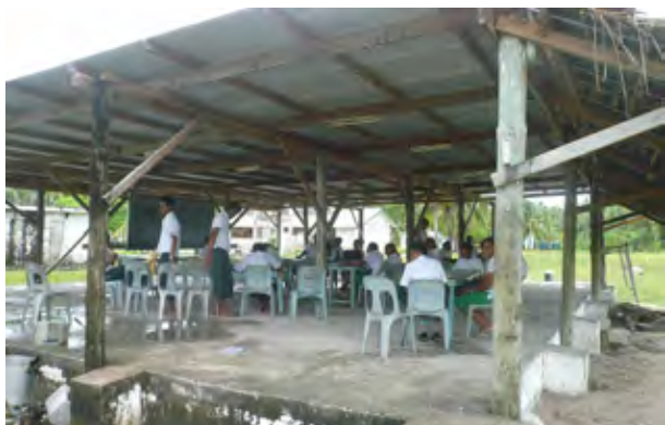
埋設貯水槽上部に屋根を掛けて教室にしている。職業訓練コースの2 クラスが合同で使用している。
