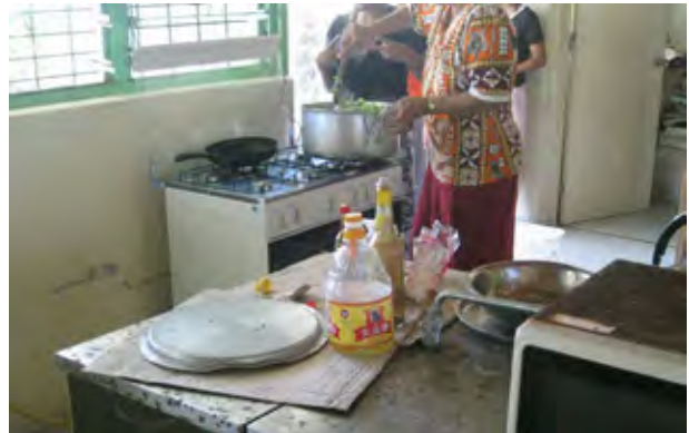
調理実習の様子。実習台はステンレスの甲板に錆が拡がり、組込機器が機能しないため別途コンロ台を持込んでいる。
