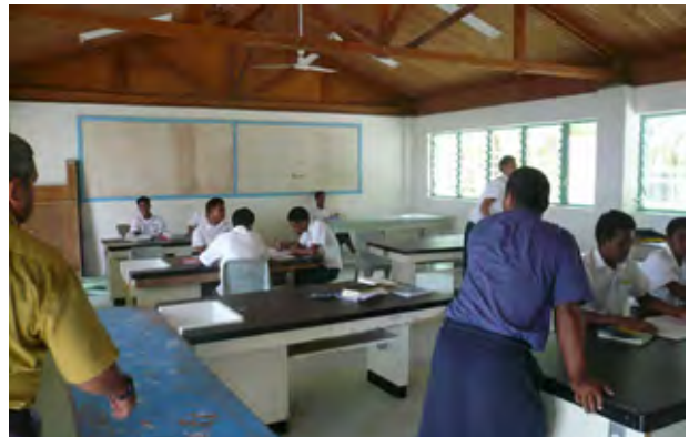
特別教室棟、化学実験室。給排水・電気が機能しないため本格的な実験授業は行えていない。
