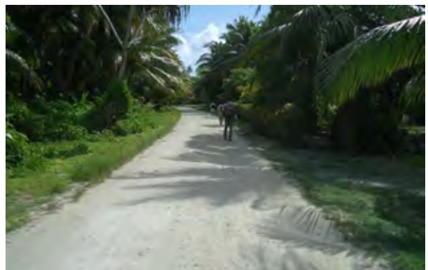
島の中心集落からモトフォウア校へ至る道路。未舗装だが状態は良く、雨期の通行も問題ない。
