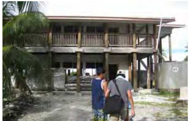
フナフチ環礁を構成するアマツク島の船員養成所 (TMTI)。ADB 支援の施設拡充を実施中。、写真は増築中の教室棟。
