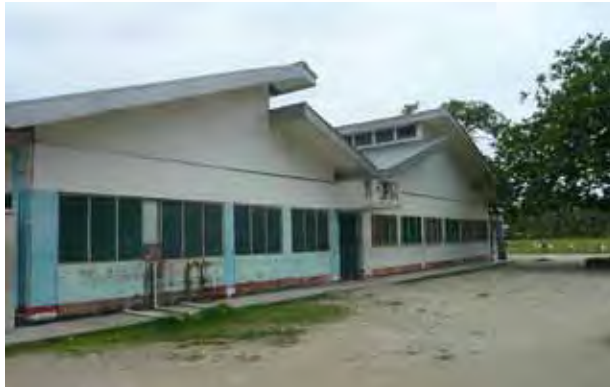
食堂・厨房棟。他施設に比べると状態は良い。手前厨房部分はピロティを塞いで室となっており、配管も替えられている。
