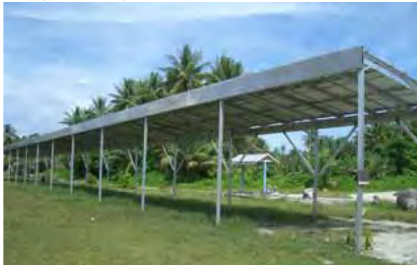
2010年1月完成の太陽光発電設備。イタリア政府援助による。発電容量は46kW。
