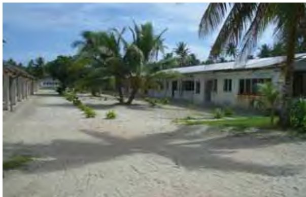
教室棟建設予定地。右手の既存教室棟は撤去の予定。
