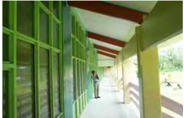
Tolise 小学校新校舎。片廊下 2 階建てで廊下側間仕切りはルーバー窓を組込んだ木製パネルを採用している。
