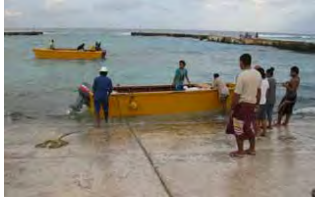
日本の無償資金協力により整備されたバイトアップ港。防砂堤とスリップウェイを備える。
