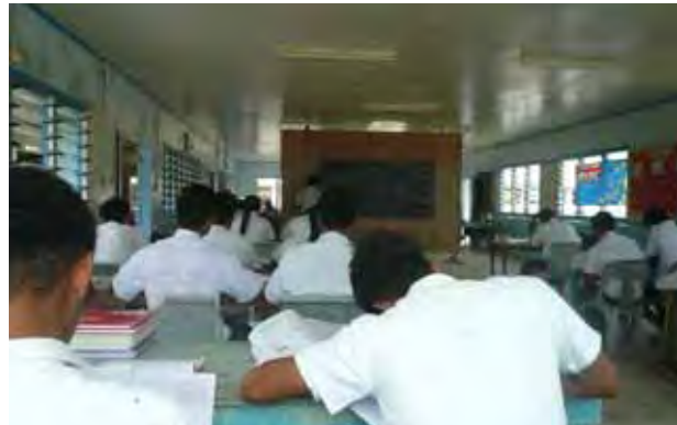
旧教員室に間仕切りを設けて2 教室で使用している。音も筒抜けで教育施設として不適切な状態にある。
