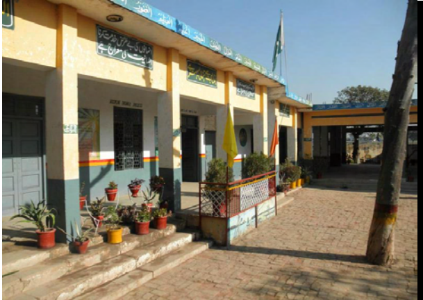
パイロット校舎概観
