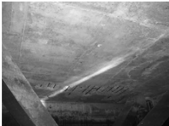
Slab bet. Pile 1E & 2E
