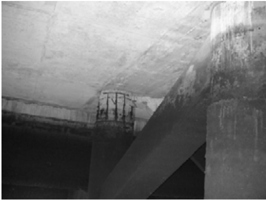
Pile 17D ~ Pile 17E
