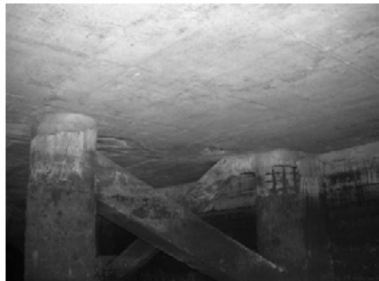
Pile 4D ~ Pile 4E
