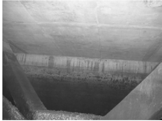
Wall bet. Pile 8E ~ Pile 9E
