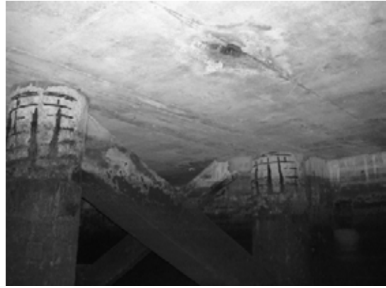
Pile 12D ~ Pile 12E-2
