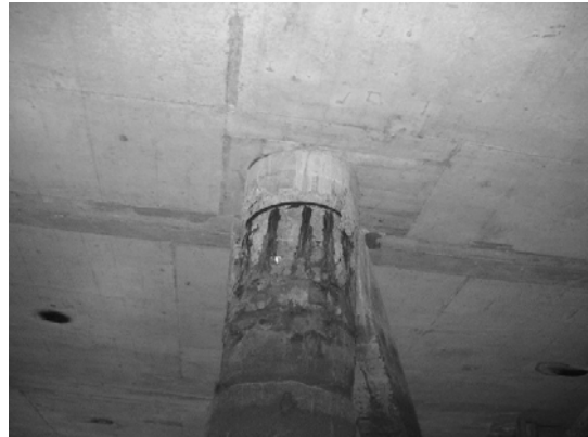
Block 3 Pile 50E-2
