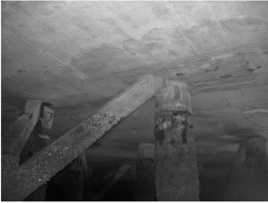
Block 3 Pile 60E
