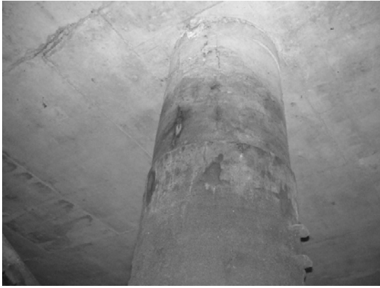
Block 3 Pile 41E-2
