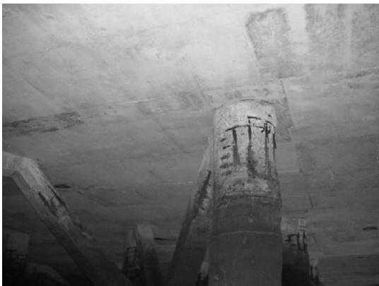
Block 3 Pile 43E
