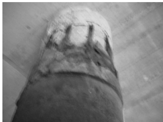
Block 3 Pile 44E
