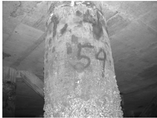
Block 3 Pile 59E
