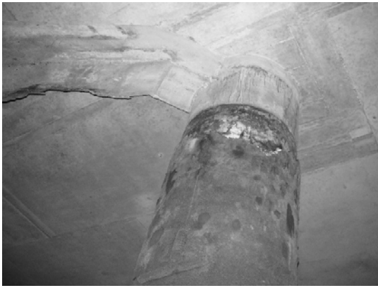
Block 3 Pile 55E
