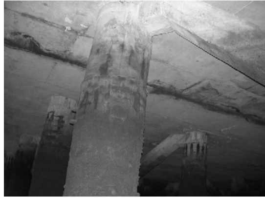
Block 3 Pile 41E-3
