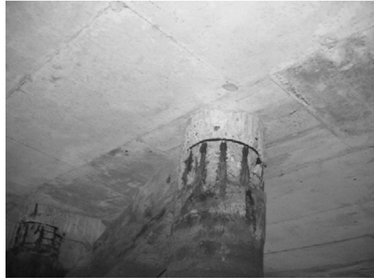
Block 3 Pile 46F ~ 46G-2
