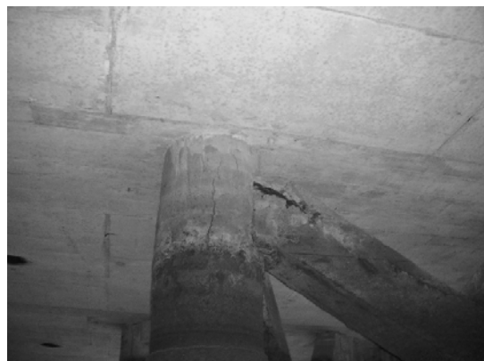
Block 3 Pile 48E
