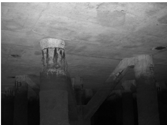
Block 2 Pile 32E
