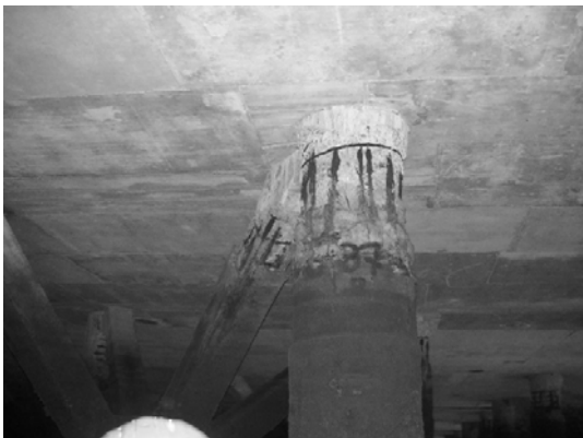
Block 2 Pile 37E
