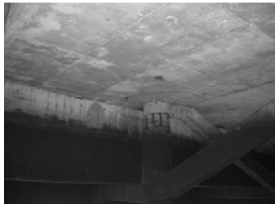
Block 2 Pile 38G
