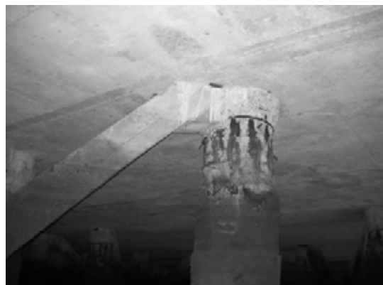
Block 2 Pile 34E
