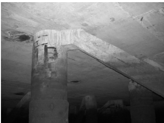
Block 2 Pile 33E
