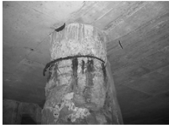
Block 2 Pile 32C-2
