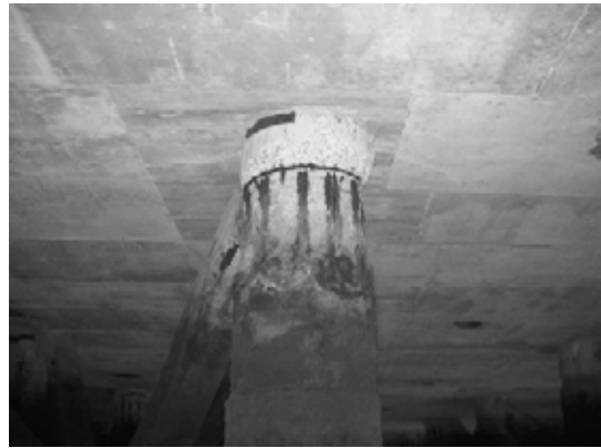
Block 2 Pile 19E
