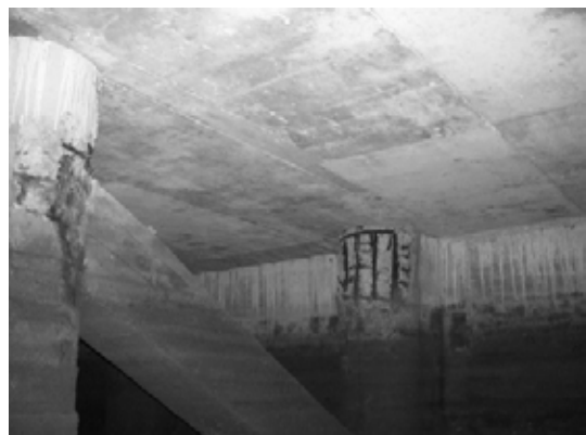
Block 2 Pile 20A
