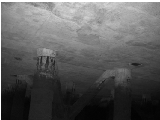
Block 2 Pile 34D ~ 34E
