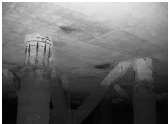
Block 2 Pile 30D ~ 30E
