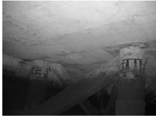
Block 2 Pile 30F ~ 30G
