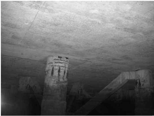
Block 2 Pile 32C-1
