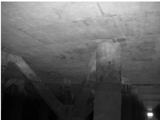
Block 2 Pile 39E
