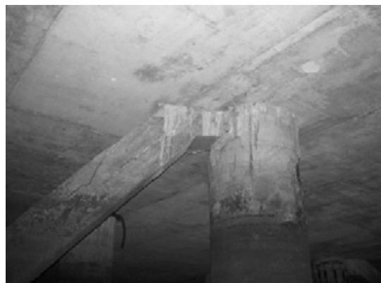
Block 2 Pile 20E
