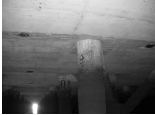
Block 2 Pile 30E-2
