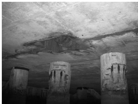
Block 2 Pile 18a ~ 18C
