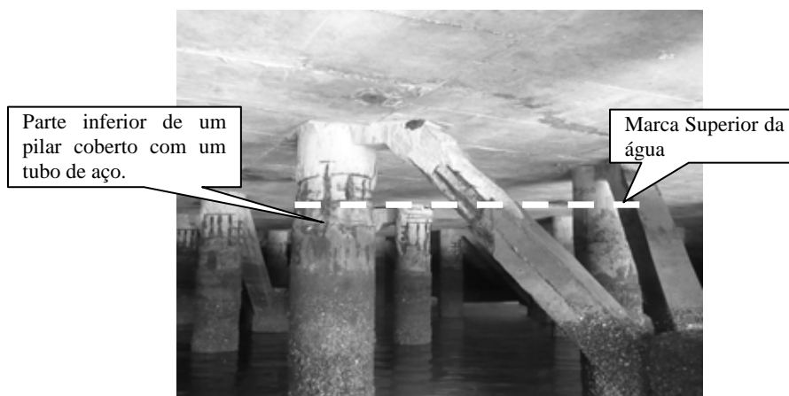
Figura 4.1-9 Geral vistas sobre Montes danificados e adereços sob o pavimento de concreto
