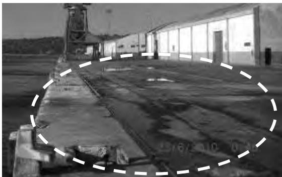
Figura 4.1-28 Assentamento de trituradas
