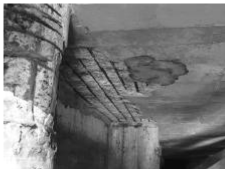
Figura 4.1-12 Soltura do pavimento de concreto de nas 1 as e 2 as colunas
