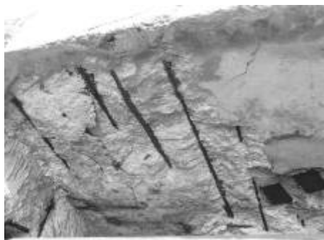
Figura 4.1-11 Concreto do baixo deck com sinais de soltura na extremidade norte
