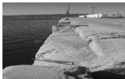
Figura 4.1-24 Tampa deteriorada de concreto do terminal de carga geral
