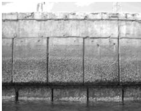
Figura 4.1-13 Face de blocos de concreto
