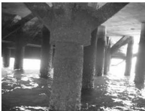
Figura 4.1-10 Suporte pilha com cabeça e adereços
