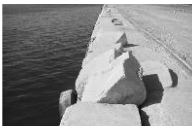
Figura 4.1-24 Tampa deteriorada de concreto do terminal de carga geral
