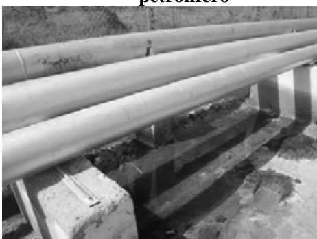
Figura 2.7-12 Derrame no pipeline
