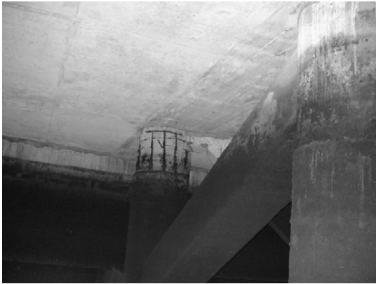
Pile 17D ~ Pile 17E
