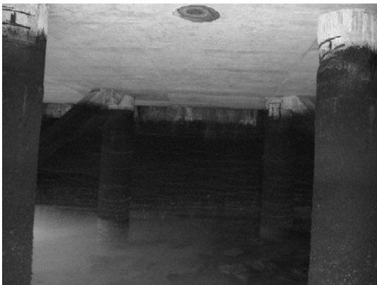
Pile 24C ~ Pile 24D Pile 25C ~ Pile 25D
