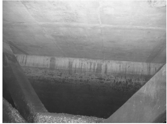
Wall bet. Pile 8E ~ Pile 9E
