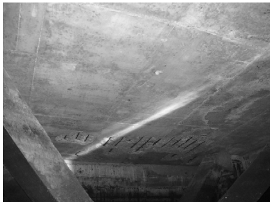
Slab bet. Pile 1E & 2E
