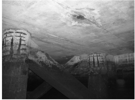
Pile 12D ~ Pile 12E-2
