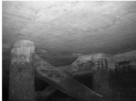
Pile 4D ~ Pile 4E
