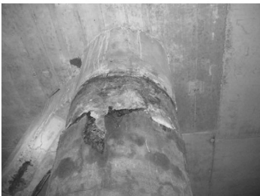
Block 3 Pile 60C
