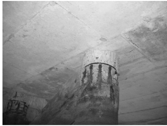
Block 3 Pile 46F ~ 46G-2
