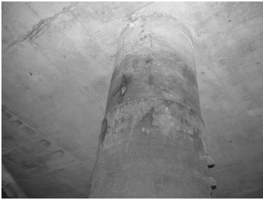
Block 3 Pile 41E-2
