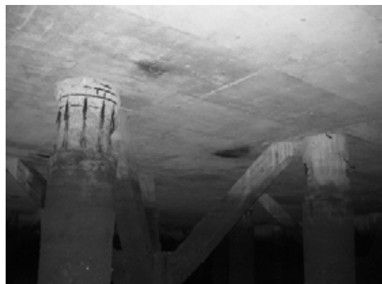
Block 2 Pile 30D ~ 30E
