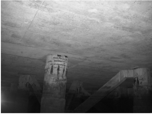
Block 2 Pile 32C-1
