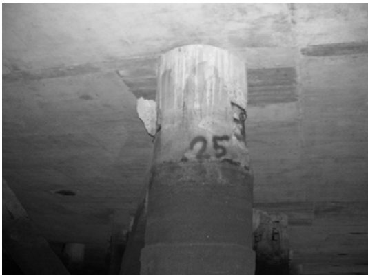
Block 2 Pile 25E
