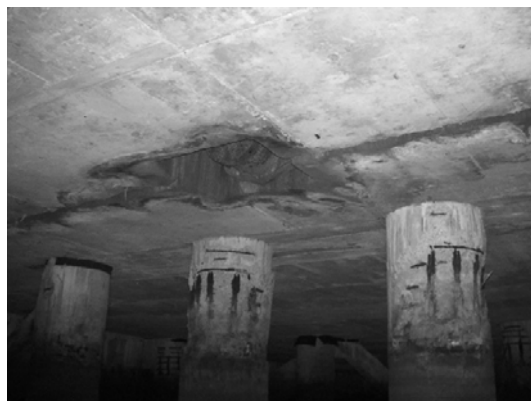
Block 2 Pile 18a ~ 18C
