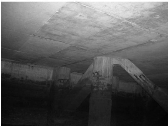
Block 2 Pile 25A ~ 25B
