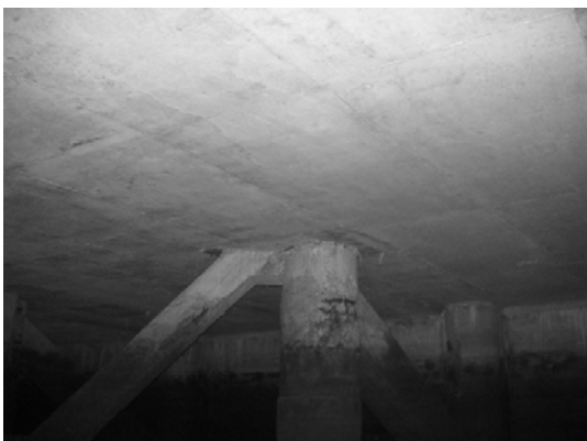
Block 2 Pile 24A ~ 24B
