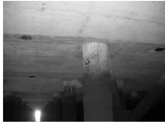
Block 2 Pile 30E-2
