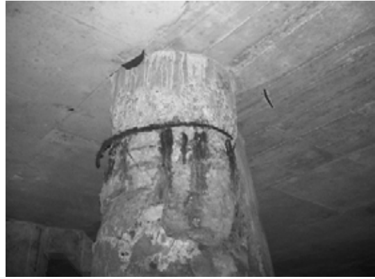
Block 2 Pile 32C-2
