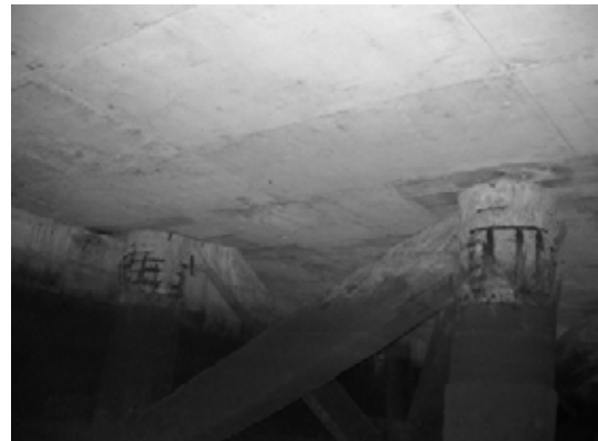
Block 2 Pile 30F ~ 30G
