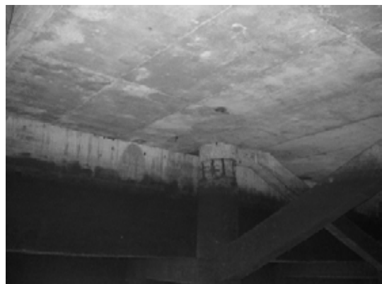
Block 2 Pile 38G
