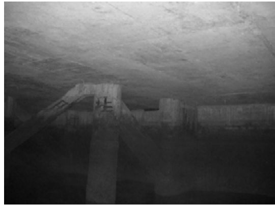
Block 2 Pile 30A ~ 30B
