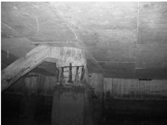
Block 1 Pile 11B-1
