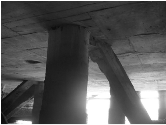
Block 1 Pile 3E
