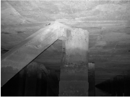
Block 1 Pile 9E-2
