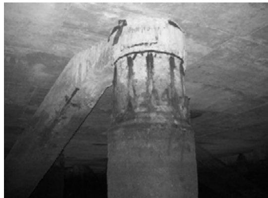
Block 1 Pile 14E
