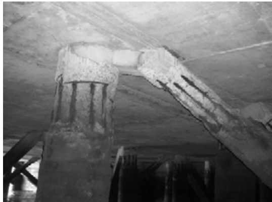
Block 1 Pile 6E
