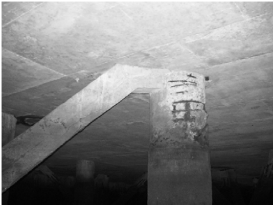
Block 1 Pile 11E
