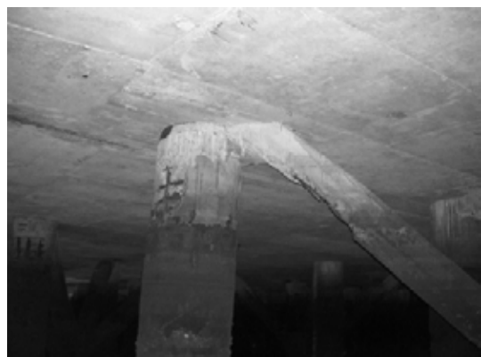
Block 1 Pile 13E
