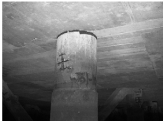
Block 1 Pile 10E-2
