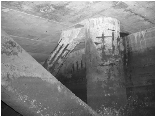
Block 1 Pile 6G
