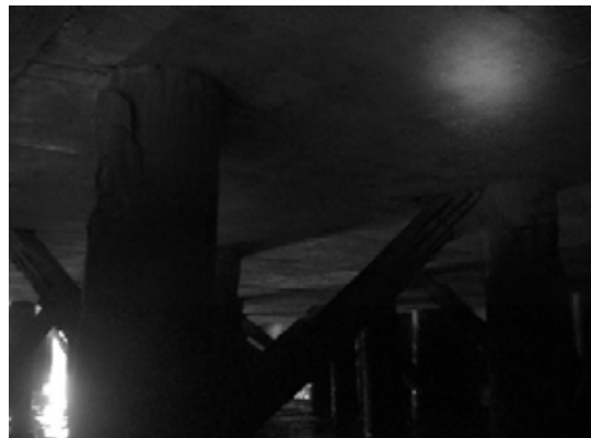
Block 1 Pile 9E-1
