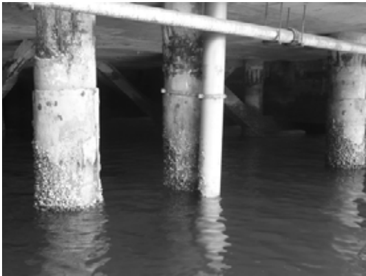
Block 1 Pile 1b ~ 1E
