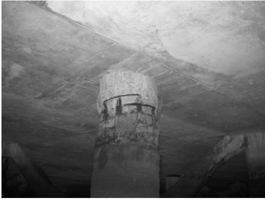
Block 1 Pile 15E-2
