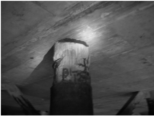
Block 1 Pile 12E
