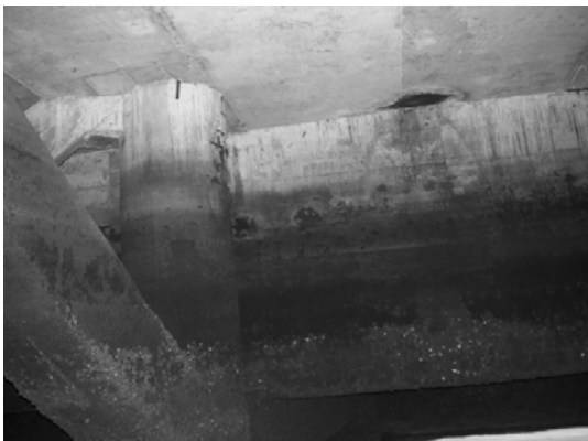
Block 1 Pile 8G
