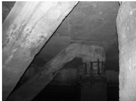
Block 1 Pile 11B-2
