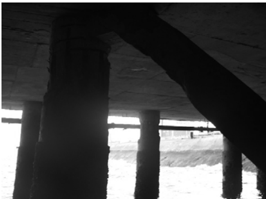
Block 1 Pile 2E
