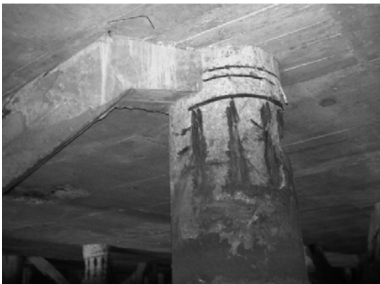
Block 1 Pile 5E
