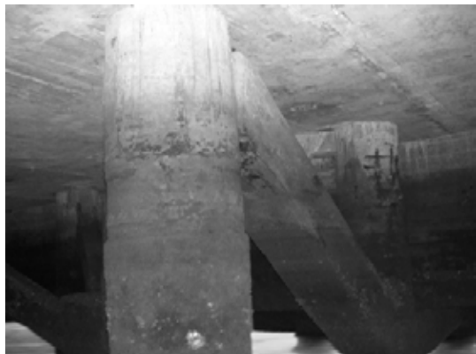
Block 1 Pile 6F ~ 6G
