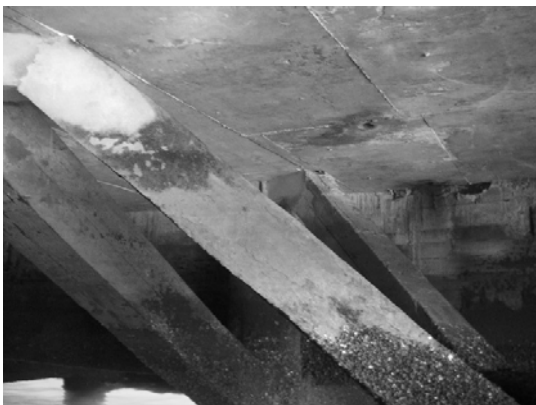
Block 1 Pile 101c-1
