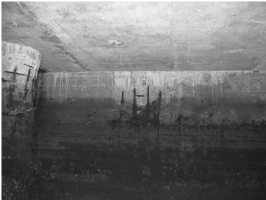
Block 1 Wall bet. Pile 5G & 6G
