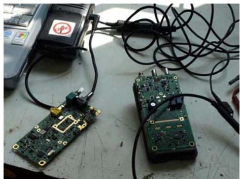
修理作業中の携帯式 VHF 通信機。
