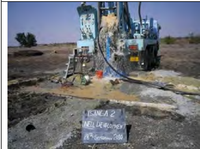
3：試掘調査（デベロプメント作業）
