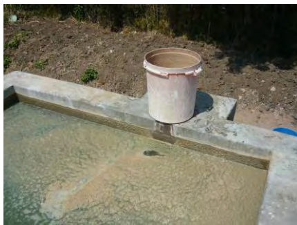
現在の凝集剤注入点（着水井の手前側）
