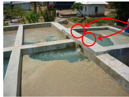
変更後の凝集剤注入点（着水井からの流出部上流側）
