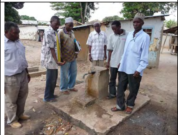
12：稼働中の管路給水施設 (タボラ・ルーラル県)
