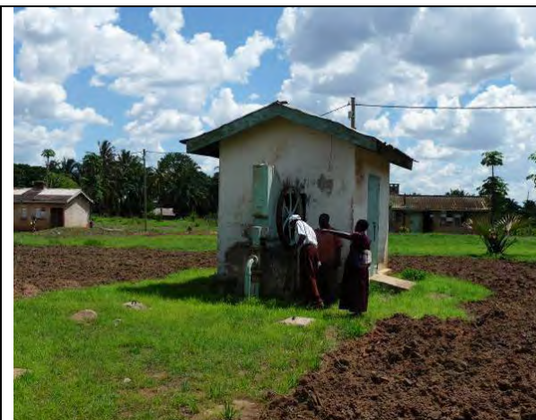
14：故障して稼働停止中の管路給水施設 （ウランボ県）
