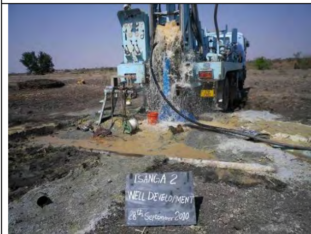
21：試掘調査（ディベロップメント作業）
