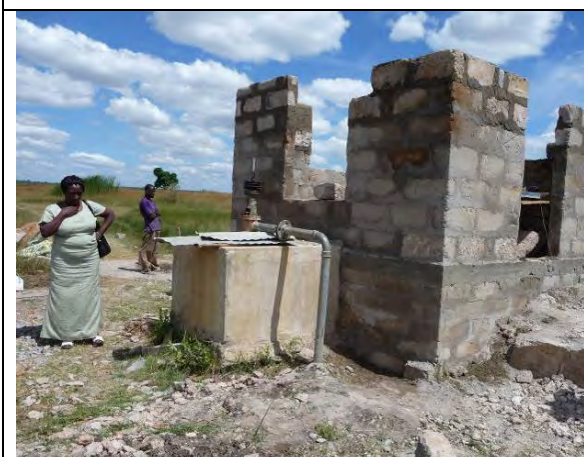
5：改修中の管路給水施設（レバル-2）（ンゼガ県）
