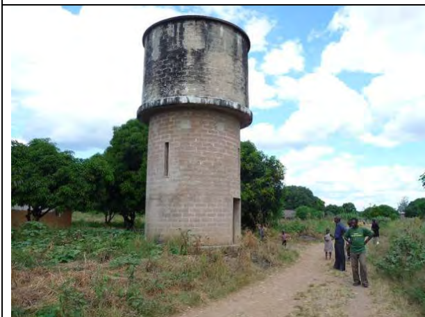
11：放棄された配水タンク (シコンゲ県)
