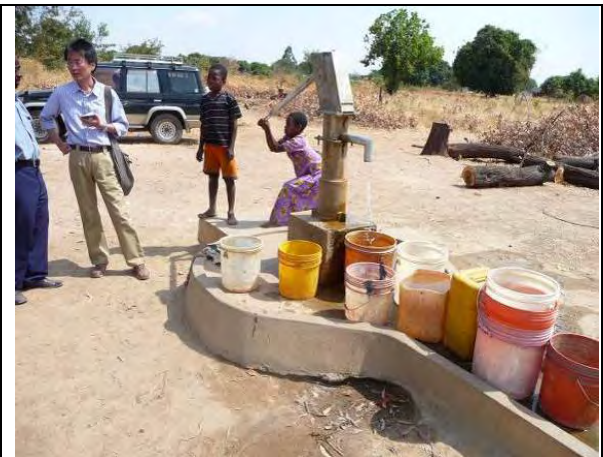
8：浅井戸に設置されたハンドポンプから水を汲む 少女 (タボラ市)
