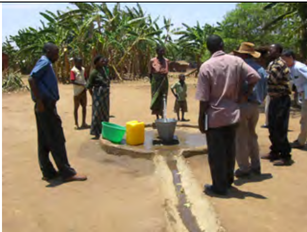
⑪MoIWDにより運営されているムチンジ重力給水システム 1975年に建設。使用料金は徴収されていないが、タップ委員会により、タップ交換費用充当に一定額を徴収している。
