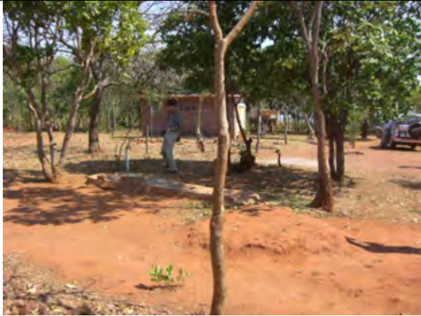
⑦Tikoliwe 地区パイプ給水システムの水栓施設
