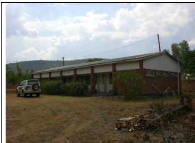
①ムテンジ県水開発事務所 (撮影日:2010年11月4日)
