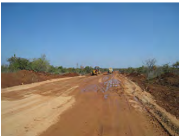
LS-MFEZ(敷地内部) 敷地内道路整備状況。
