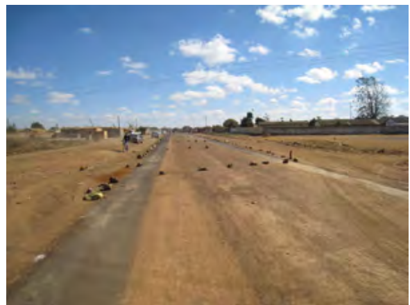
カサマ道路 ザンビアにより舗装工事完了。
