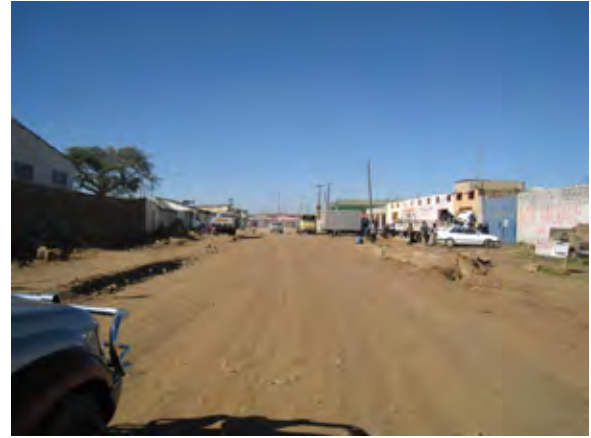
ムラリラ道路 現道は土道で交通量は少ない。
