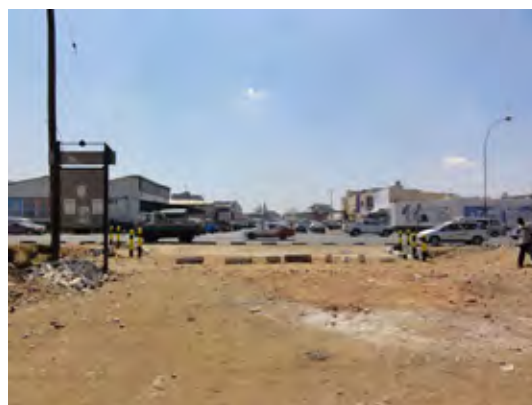
写真 2-2-2 ムラリラ道路延長の状況 (J1 交差点接続部)
