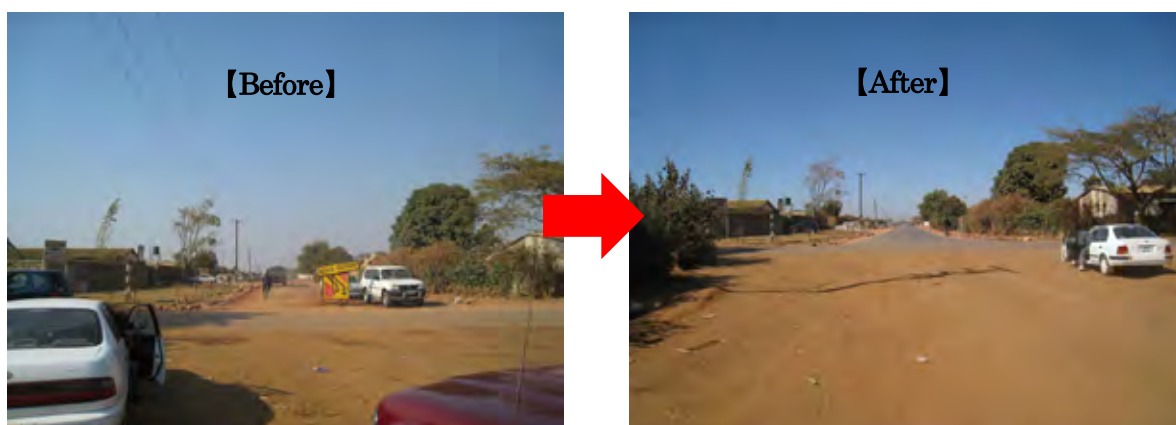
写真 2-2-9 シャンツンプ道路（南側）は調査期間中に地元業者による舗装工事が行われた
