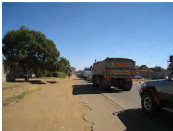
市内既存道路状況(チリンブル道路) 内環状道路供用後は渋滞解消が見込まれる。
