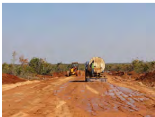
写真 2-2-11 建設中のフェーズ I 区画内道路
