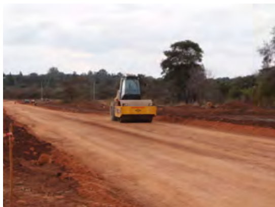
写真 2-2-10 建設中のチフエマ道路
