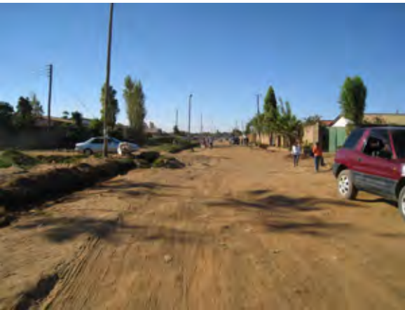
チブワ道路 ザンビアにより舗装工事実施予定。
