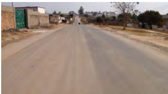
ムシオツヤ道路(北、インディペンデンス通り側) 舗装済み区間の走行性は良好。
