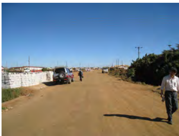
ヨータムムレヤ道路 ザンビアにより舗装工事実施予定。
