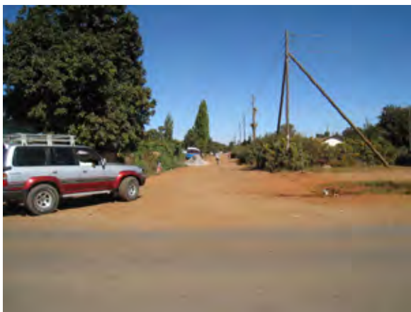
シャンツブ道路(北、チリンブル道路側) 現道は土道で、交通量は少ない。
