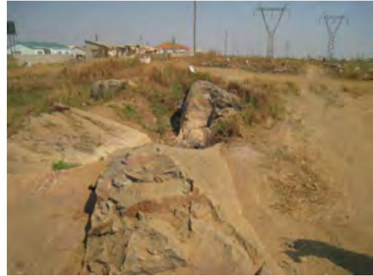
写真 2-2-7 露出した岩（内環状線）
