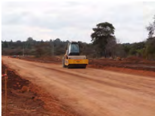
写真 2-2-10 建設中のチフエマ道路
