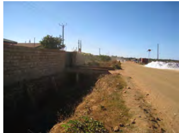
ナショナリスト道路 ザンビアにより舗装工事実施予定。
