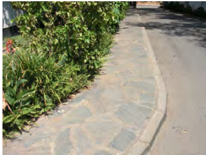
写真 3-2-1 石張り歩道の例（ルサカ市）
