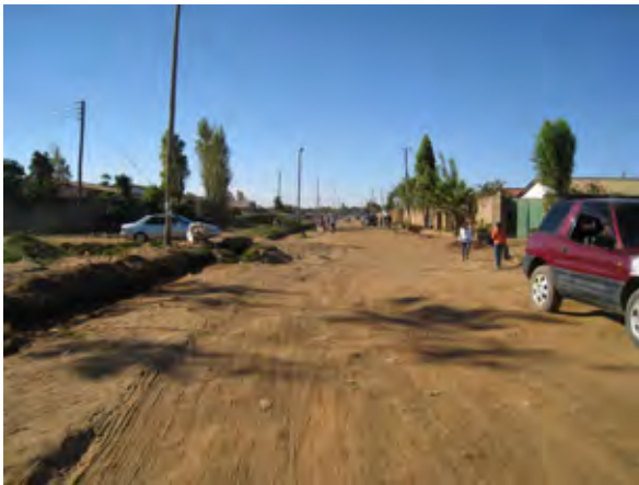
チブワ道路 ザンビアにより舗装工事実施予定。
