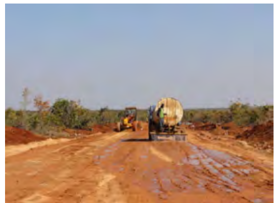
写真 2-2-11 建設中のフェーズ I 区画内道路
