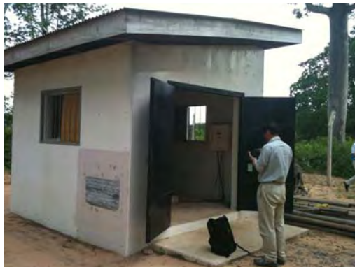
無償で建設した給水施設の稼働状況
