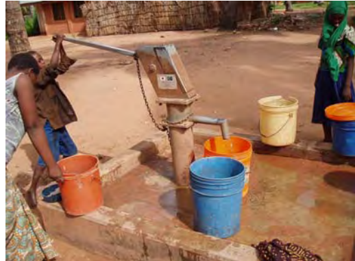
無償(首都圏周辺地域給水計画)で建設した給水施設の使用状況(その2)
