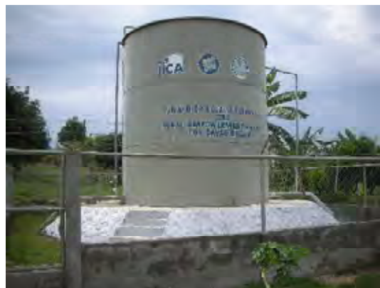
南ダバオ州のパイロット事業でマタナオ町バランガイ・バンガルに建設された給水施設
