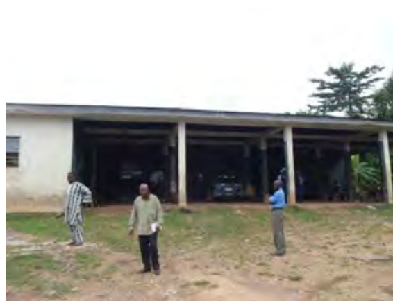
WATSAN プロジェクト事務所敷地内の資材倉庫ワークショップの外観。十分な広さを持ち堅固な構造であり盗難の心配ない。
