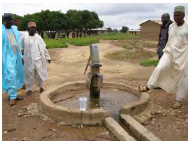
「ナ」国側が建設したワサグ村の深井戸状況。集落の中心に井戸が位置している。井戸周辺には住居・畑はなく、広場となっている。村落住民組織が井戸の維持管理を行っている。
