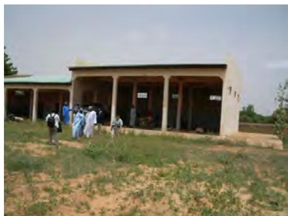
ケッピ州 RUWASSA のワークショップ家屋の状況。外装・内装ともに良く整備され十分な広さを持っている。
