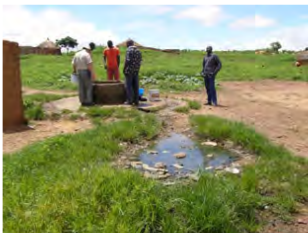
サボ・ゴンダ村の手掘り浅井戸の状況。この地区で唯一の井戸であり、乾季には井戸は枯れる。その時は、遠方のニジェール川へ水を汲みに行かなければならない。
