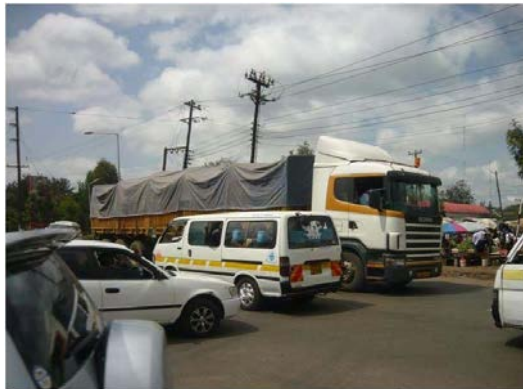
1+10交差点付近 ウゴンゴ道路では、大型車両が通行する。 信号制御がなく、側道から右折する車両が割り 込み、本線車両の交通流の妨げとなっている。
