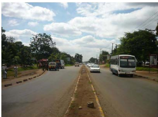
00+20付近 現況は片側1車線であるが、車道幅員は通常より広い。また道路拡幅用の用地は確保されている。
