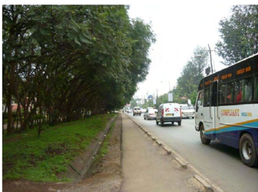
2+400付近(上り線側) 美しいジャカランダの並木道があり、枝が車線上に張り出してあり交通安全上、枝払いが必要であるが、基本的に伐採しない計画とする。
