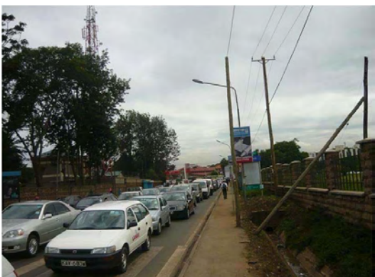
2+800付近 夕方時のシティモーチュアリーラウンドアバウトに流入するパレロードの車輛渋滞状況である。現況交差点のロータリー交差点改良が必要である。
