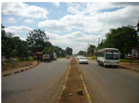
00+20付近 現況は片側1車線であるが、車道幅員は通常より広い。また道路拡幅用の用地は確保されている。
