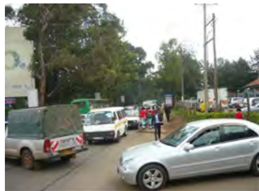
3+350交差点付近 前車に続き、強引に本線へ割り込む車両で本線 車両の交通流を妨げている。 側道からの右折禁止や信号制御等の交差点 改良が必要である。
