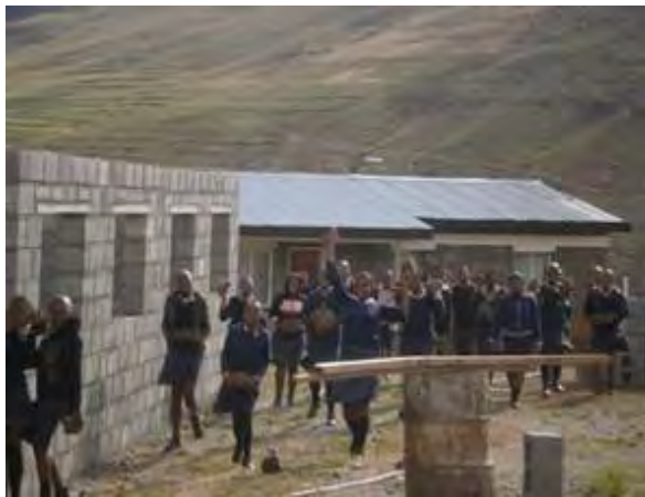
■教員住居（写真奥）/セント・テレザ前・後期 中等学校（ターバツェウカ県） 学校敷地内の教員住居。手前は自助努力で建設中の 職員室。
