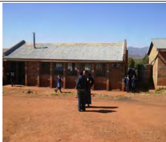
■雨水タンク/レリベ県にある類似既存中等学校。 理科実験棟および教室棟。 雨水集水し、農業実習畑へ再利用を行っている。
