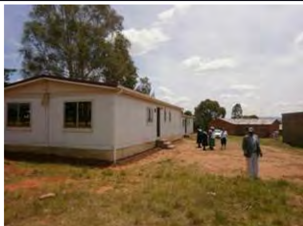
■既存校校舎/リナレン中等学校（レリベ県） プレハブ仮教室外観。奥の教会堂も、週末を除き、 教室として使用している。
