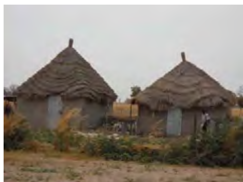
マーケットガーデニングの管理人宅と畑作人の休憩小屋(兼肥料、農具置き場)
