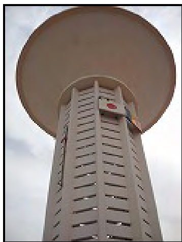
給水塔 (日本・セネガルの国旗と水位計の設置がある) マレメニアニ (直接サイト)
