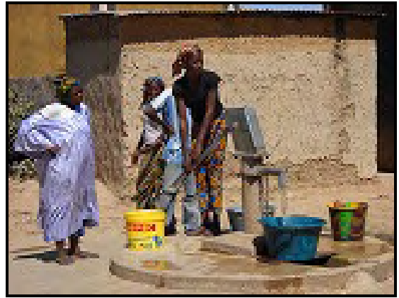
手押しポンプでの取水状況 ベマ (手押しポンプサイト)
