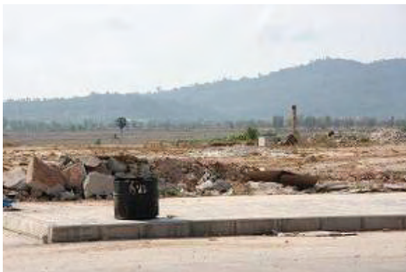
写真14 工事中の中国 SEZ
