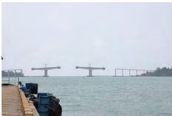
写真7 コップス島への橋梁工事
