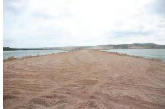
写真13 ストゥンハブ SEZ 工事状況
