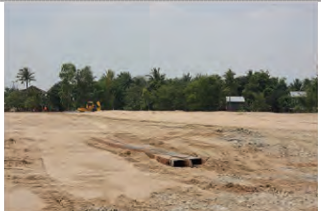
プノンペン新港の埋め立て
