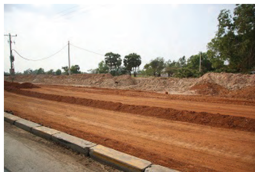
写真 19 国道4号線拡幅工事
