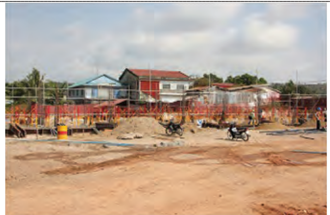
ポート SEZ 管理棟の建設。
