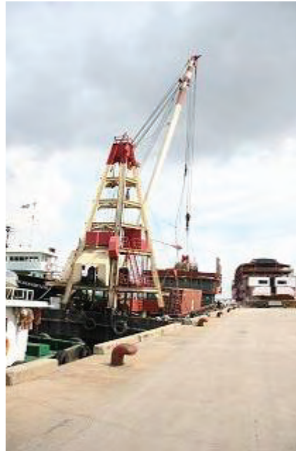
写真9 フローティングクレーンによる荷役作業
