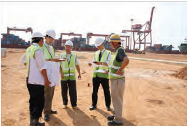
舗装工事中のコンテナヤード。舗装が完了すれば 400,000TEU/年の施設容量となる。
