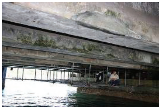
写真6 補修作業の様子
