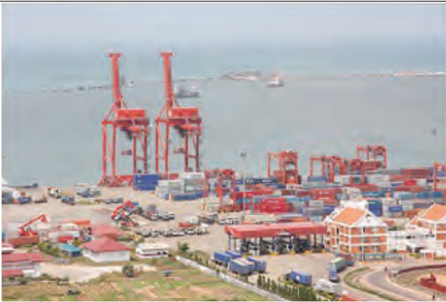
シハヌークビル港全景。ガントリークレーンのプロダクティビティは平均 24 個/時/基。
