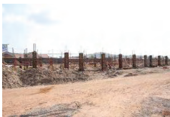
写真 11 管理棟の工事
