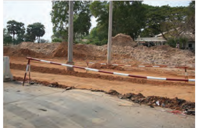
国道4号線拡張工事中。
