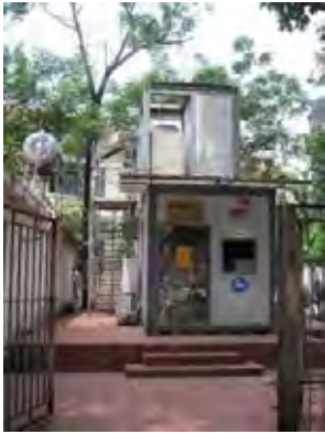
NIHE のモバイルラボ (2008 年完工 無償資金協力)
