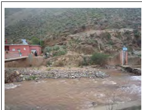
Tahanaout 水位・雨量観測所（既設）
