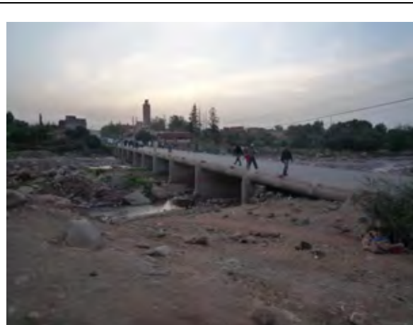
ウリカ下流洪水危険地
