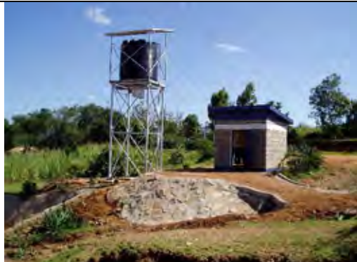
写真-8：ソーラーを動力源とした深井戸給水施設。太陽光の利用は普及し始めている。
