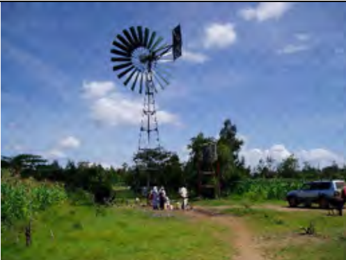
写真-7：風車を動力源とした深井戸給水施設。本事業で同型を採用する。
