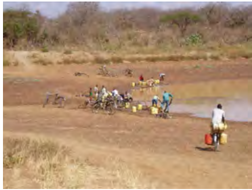
写真-2：岩盤地帯での堰止め型水源。乾期に枯渇するほか、水質に問題がある。
