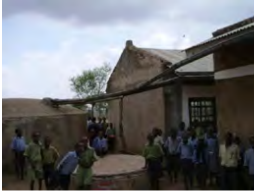
写真-3：学校に設置された雨水貯留タンク。乾期に枯渇するため、雨期のみ使用する。
