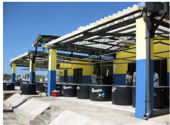
プエルト・エル・トリウフォの新規種苗生産施設
